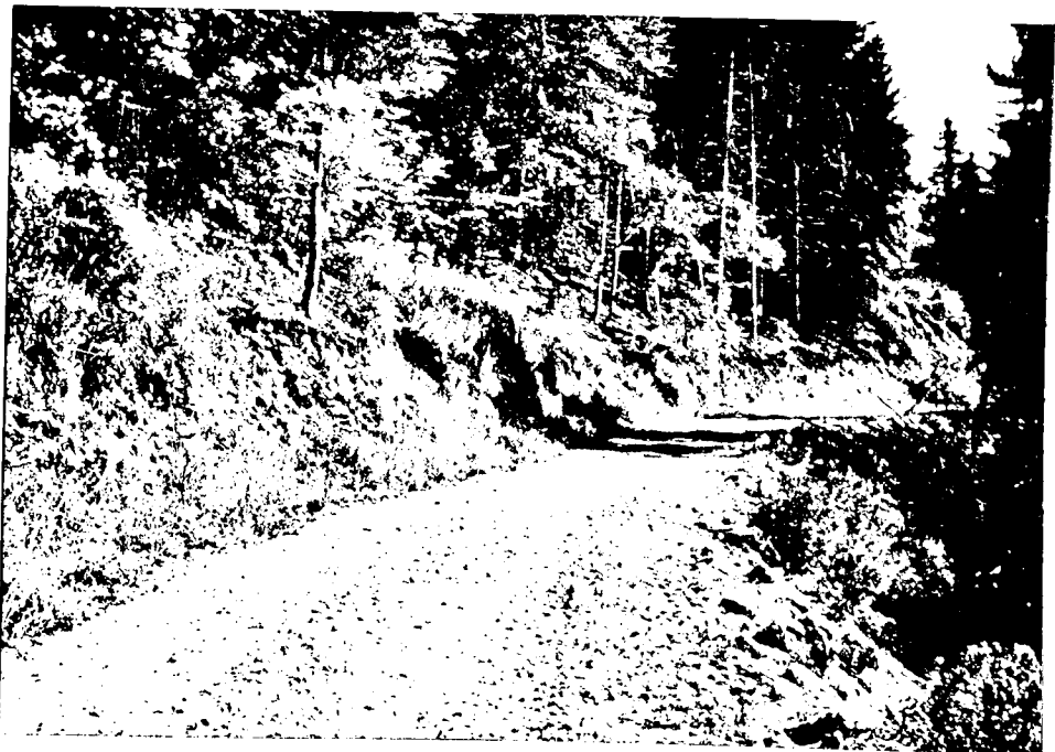
Slika 4.: V ugodnih rastiščnih razmerah se tudi odkopna brežina zaraste v 4-5 letih, cesta se spoji z okoljem.
