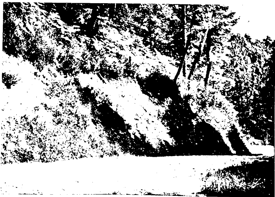
Slika 2.: Zasenčenost je eden od dejavnikov, ki omogoča naravno ozelenitev odkopne brežine na neugodni ekspoziciji.
