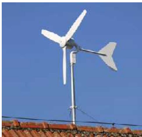
Abbildung 6: Kleinwindkraftanlage
