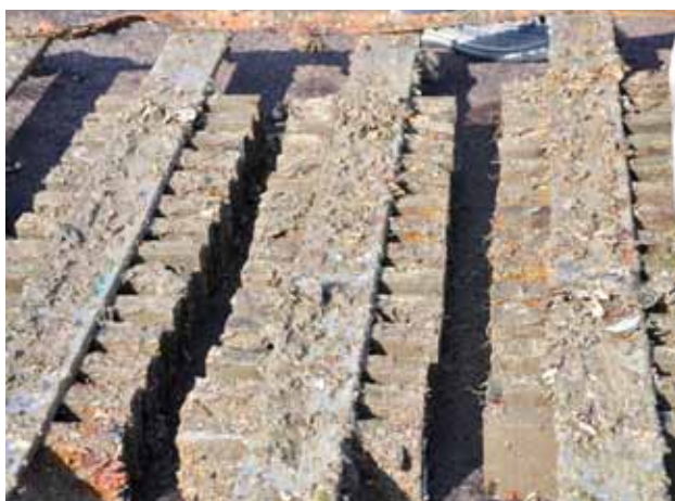
Slika 2: Vzorca na stojalu po enoletnem testiranju v morski vodi v skladu s standardom SIST EN 275
