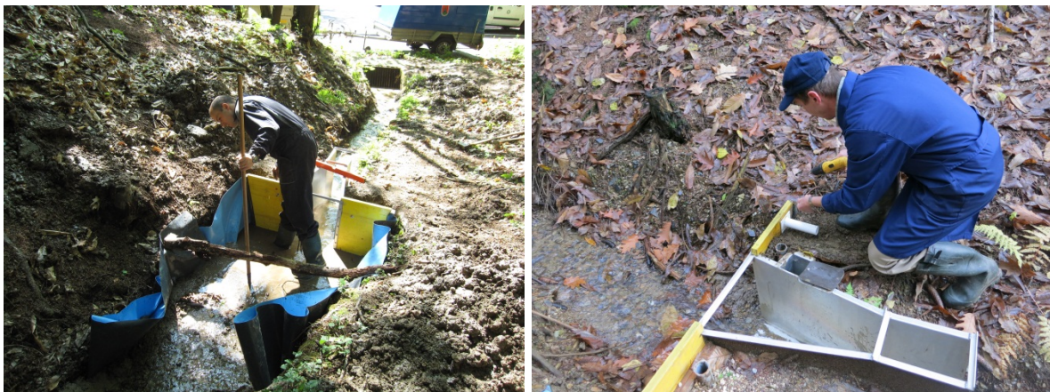
Slika 15: a) Postavitev preлива in b) namestitvev tlačnih sond za meritve vodostaja na monitorinški lokaciji Rožnik (foto: Urša Vilhar)
