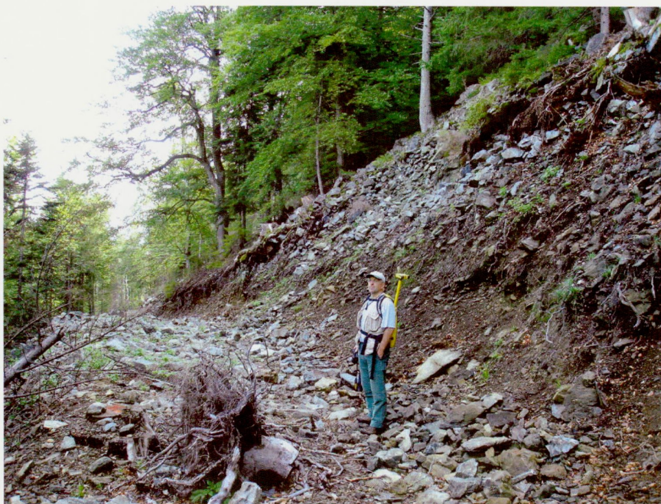
Slika 4 Posledice gradnje vlake na naklonih terena nad 50% in neugodni podlagi (foto R. Robek)
