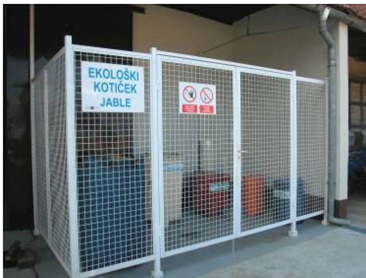
Slika 43: Ekološki kotiček je ograjen, da se prepreči dostop nepooblaščenim osebam, ter opremljen z lovilno posodo za olje v primeru izlitja olj.
