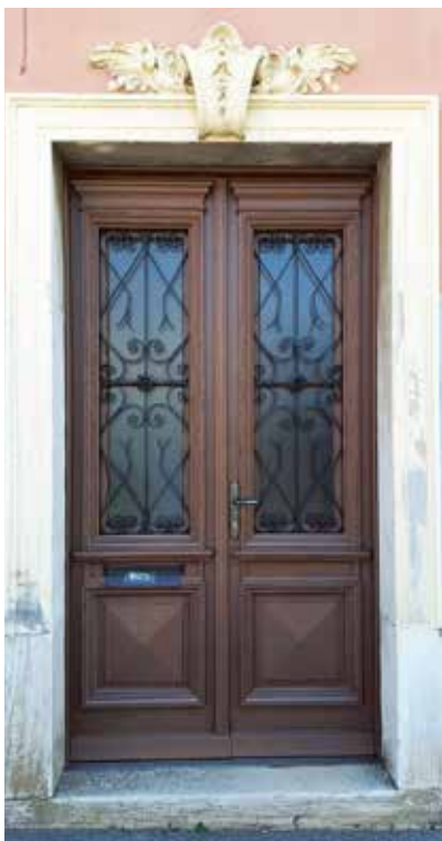
Obnovljena vhodna dvokrilna vrata
