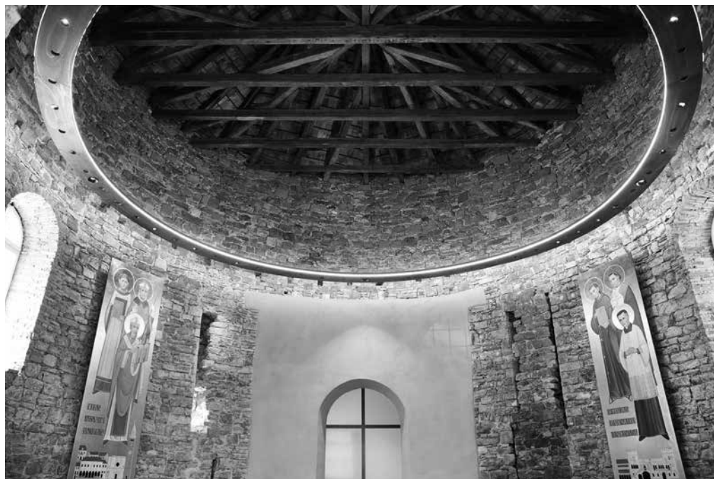
8. Koper, Marijina rotunda, notranjščina po prenovi
