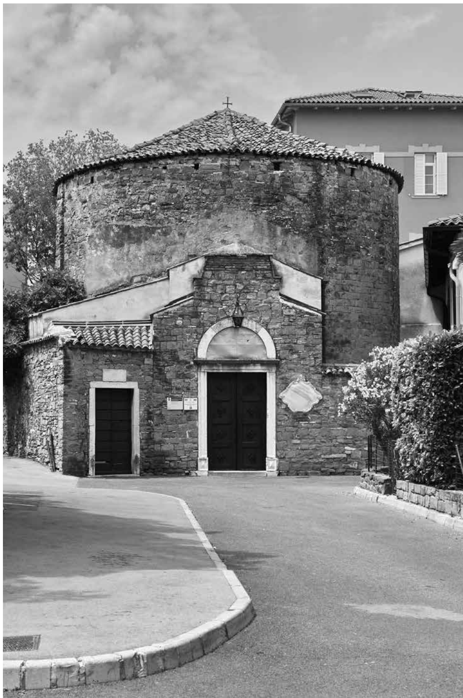
1. Koper, Marijina rotunda, zunanjščina pred prenovo
