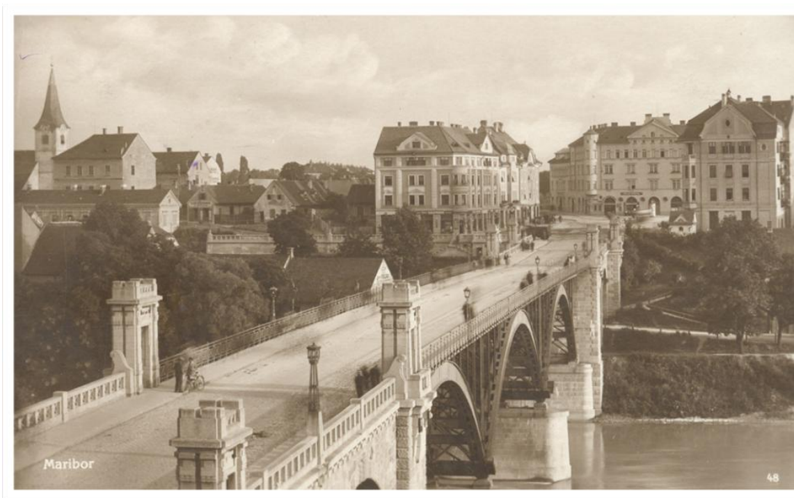
Slika 2: Državni most v Mariboru v 30. letih 20. stoletja (SI_PAM/1693 Zbirka fotografij in razglednic, 19. st.-21. st.)
