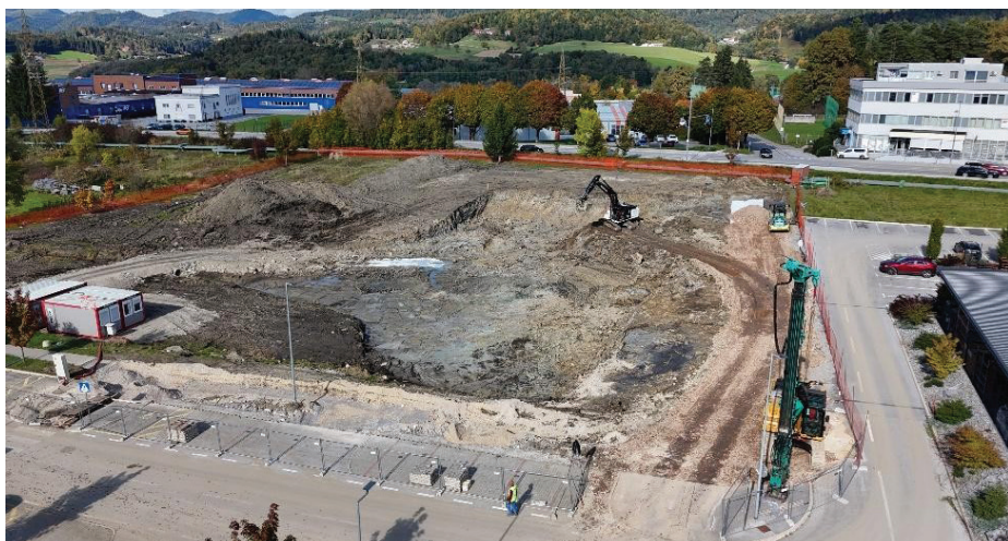
Slika 3. Izvedba zemeljskih del
