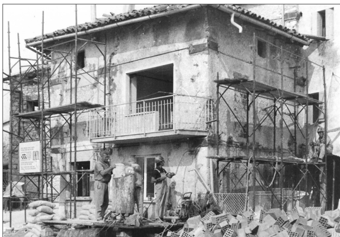
Slika 5. Utrditvena dela na hišah v zamejstvu. Levo: polaganje zidnih vezi, desno: injektiranje kamnitega zidovja (foto: E. Vugrinec)
