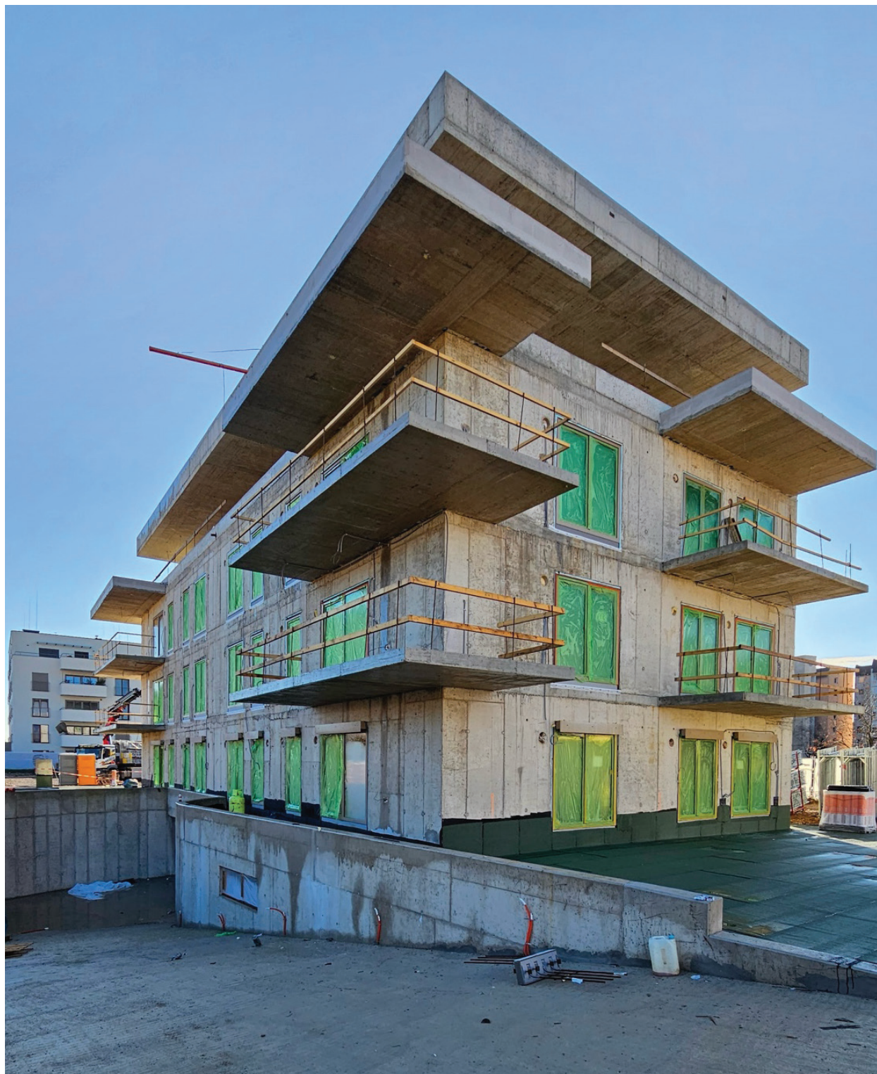
Slika 9. Dokončana AB konstrukcija z vgrajenim stavbnim pohištvom
