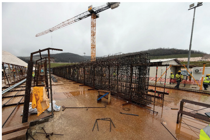
Slika 10. Armatura nosilca za most B0080
