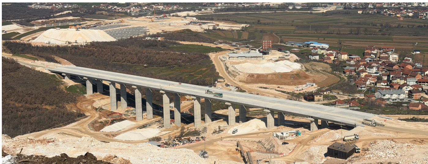
Slika 13. Gradnja mostu B00070
