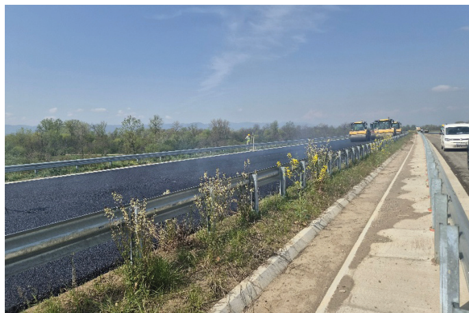
Slika 2. Izdelava zaključne asfaltne plasti na Moravskem koridorju (na dan izvedejo približno 3 km trase)
