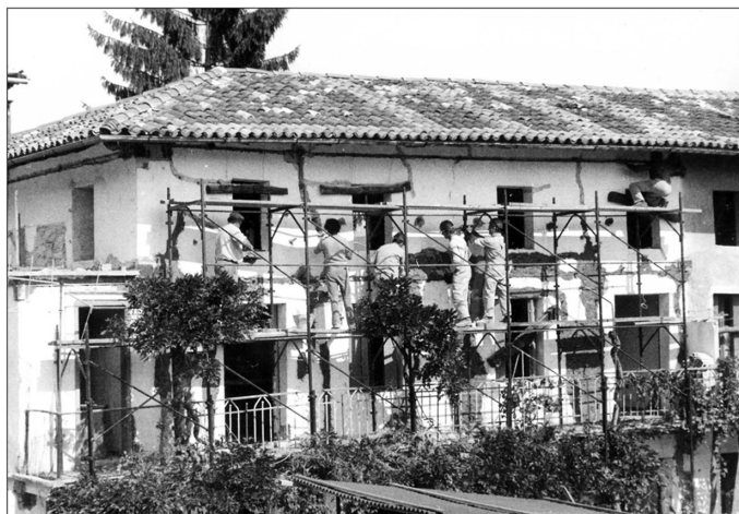
Slika 5. Utrditvena dela na hišah v zamejstvu. Levo: polaganje zidnih vezi, desno: injektiranje kamnitega zidovja (foto: E. Vugrinec)
