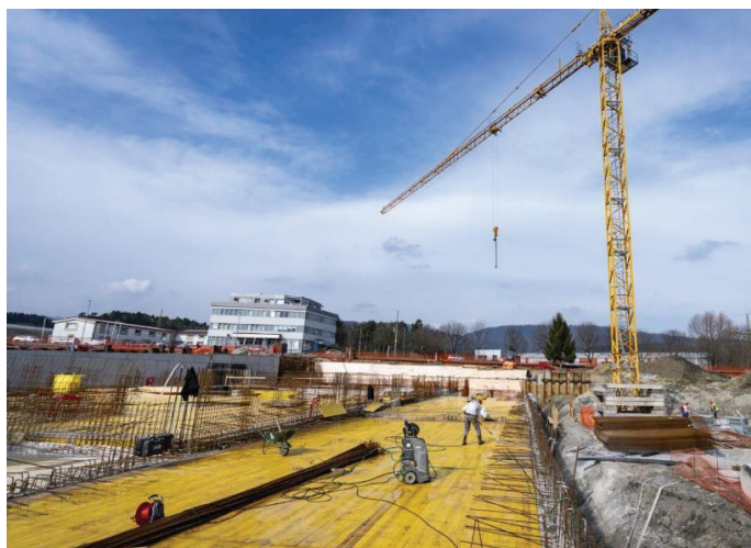
Slika 8. Začetek izvedbe prve etažne plošče
