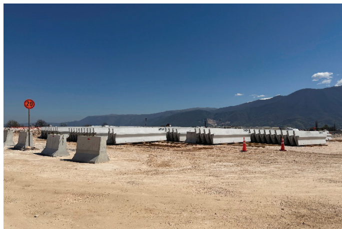
Slika 11. BVO, izdelane v prefabrikacijskem obratu
