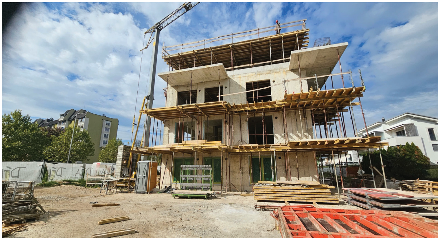
Slika 8. Pogled na lamelo B med gradnjo
