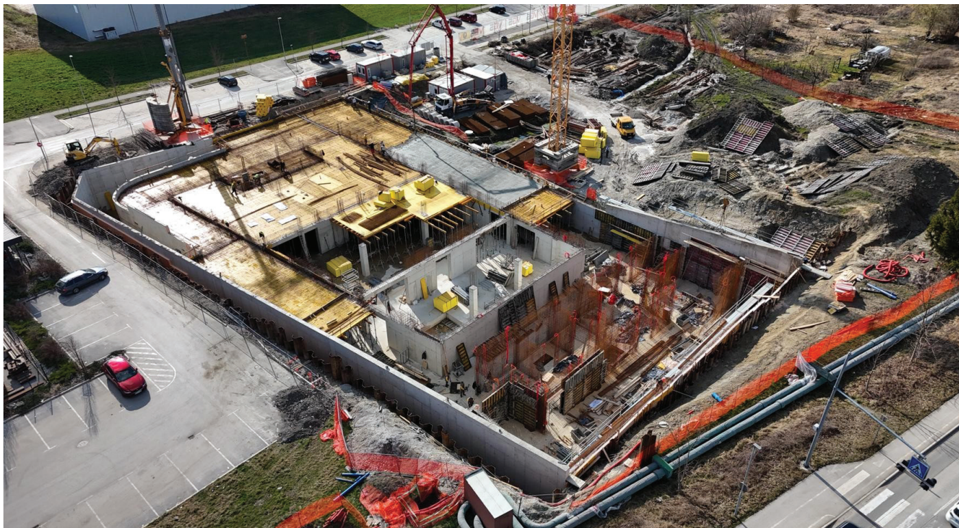
Slika 9. Trenutno stanje gradnje objekta TechHUB
