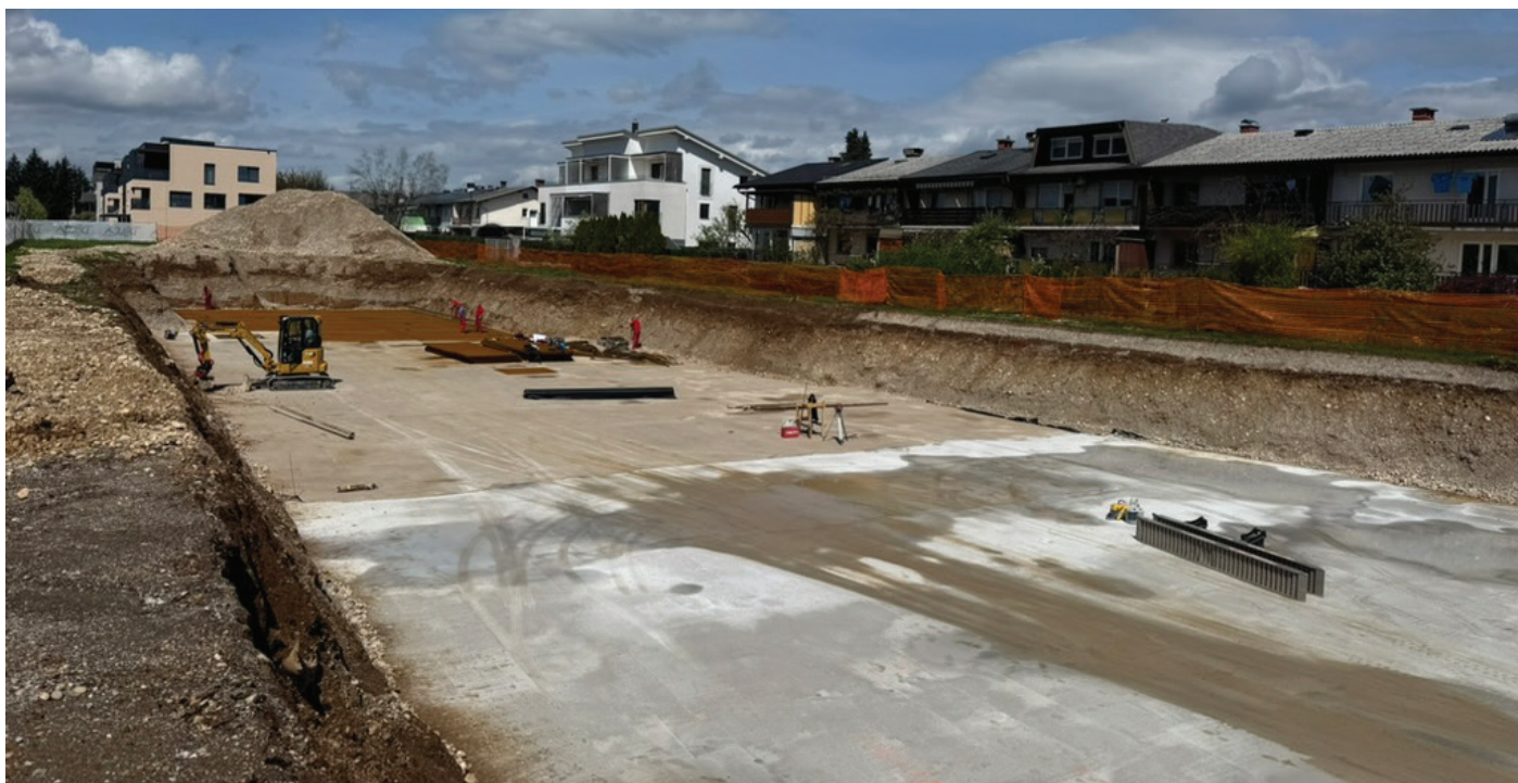
Slika 3. Priprava temeljne plošče
