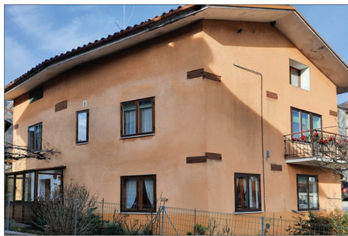
Slika 6. Hiša v Bardu (Lusevera), katere povezano in utrjeno zidovje je septembrska potresa prestalo brez poškodb. Levo: po septembrskem potresu (foto: E. Vugrinec), desno: hiša danes (foto: M. Žerajčič)
