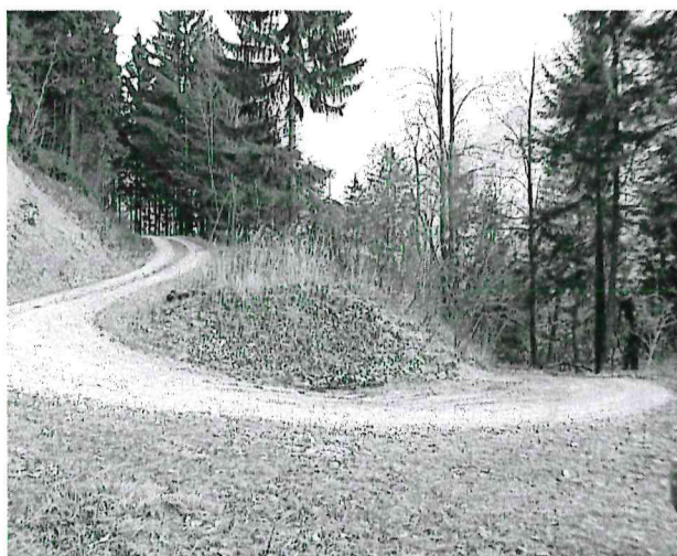
Slika 8: Serpentina in minimalni radij krivine
