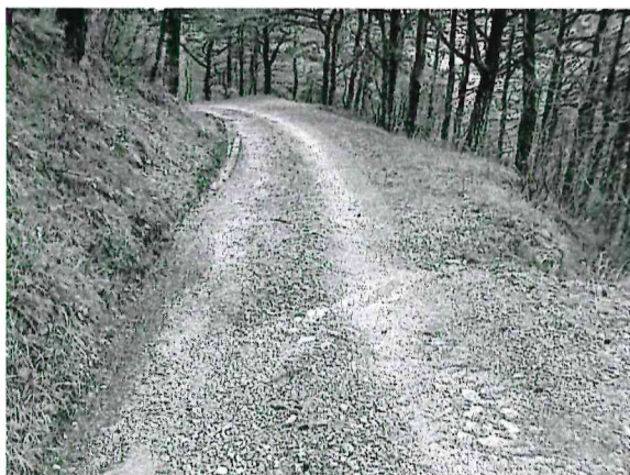
Slika 4: Koritnica in prečni jarek - urejeno odvodnjavanje zagotavlja trajnost gozdne ceste
