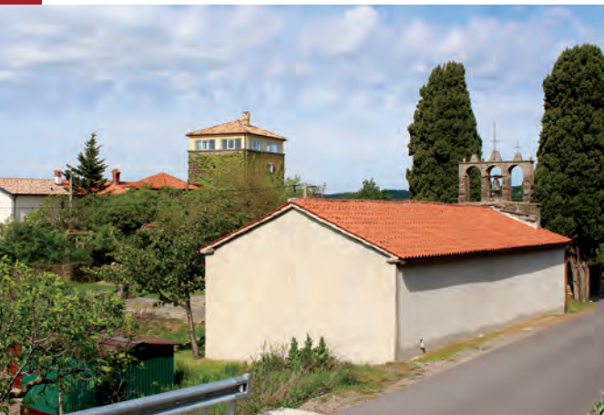
Sl. 184: Glem, obnovljen stolp in začetje cerkve blažene Device Marije (foto: D. Darovec, 2021).
