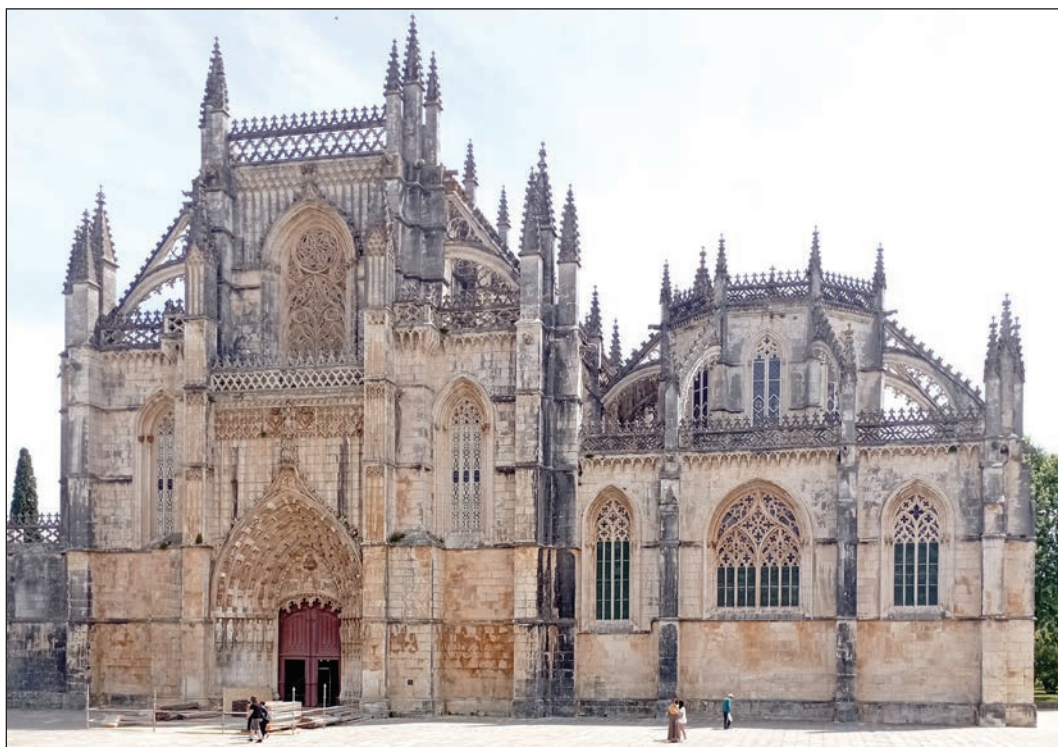
Slika 7: Samostan Batalha. Na glavno ladjo so s strani prislonjeni oporni loki (Foto: L. Pulević).
