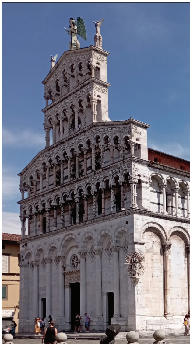
Slika 26: San Michele in Foro, Lucca. Visoka glavna fasada je pristavljena k nižjemu glavnemu volumnu (Foto: L. Pulević).
