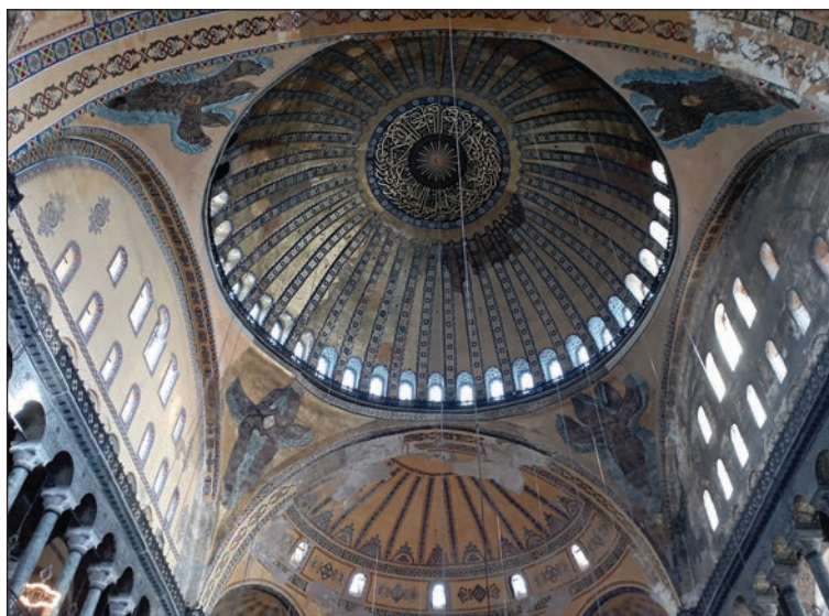
Slika 3: Hagija Sofija, Istanbul. Sile kupole so razpršene na neprekinjeno podprtje (Foto: L. Pulević).
