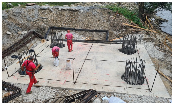
Slika 9. Priprave na izvedbo temeljne plošče
