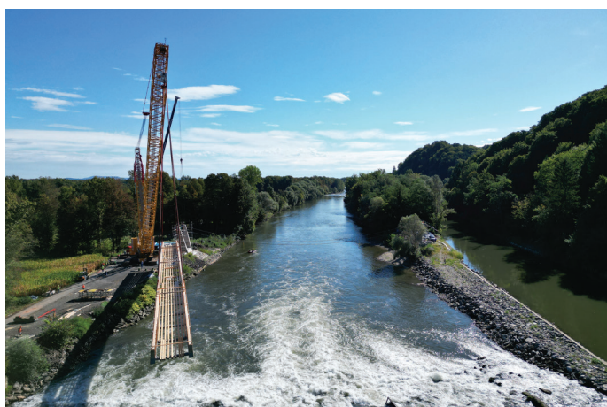
Slika 13. Vpenjanje prekladne konstrukcije, začetek montaže mostu
