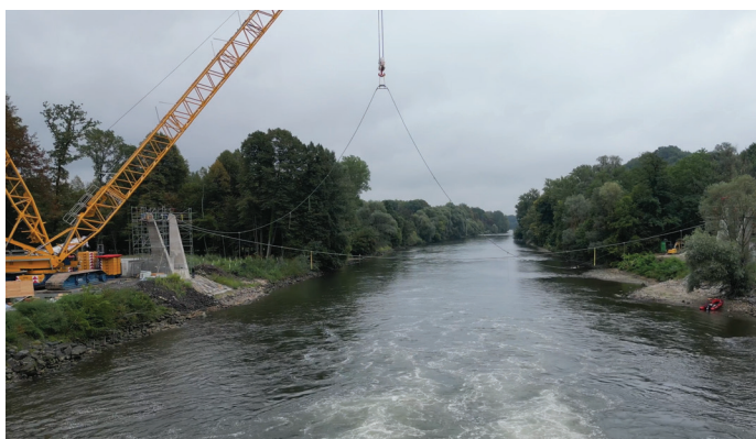
Slika 11. Montaža nosilnih vrvi
