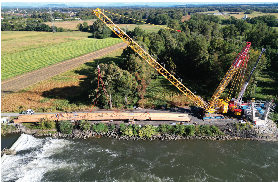
Slika 13. Vpenjanje prekladne konstrukcije, začetek montaže mostu
