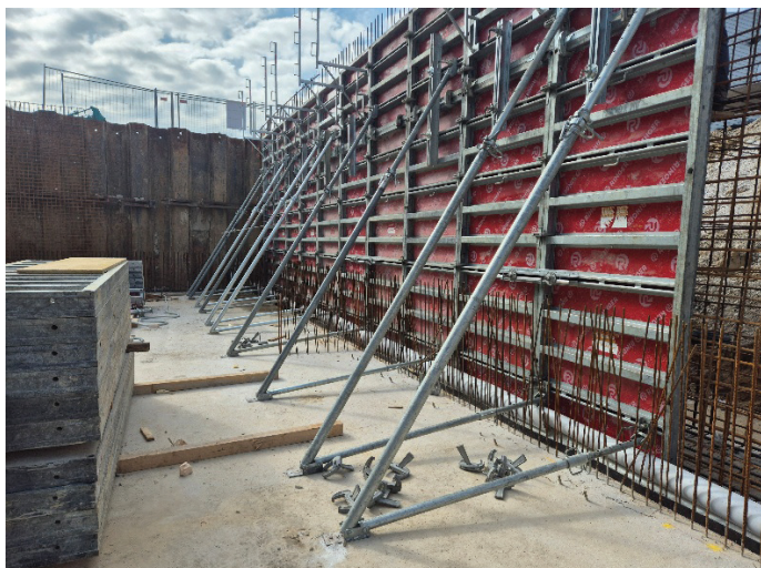
Slika 3. Opaž pasovnega temelja (foto: P. G. Volk).
