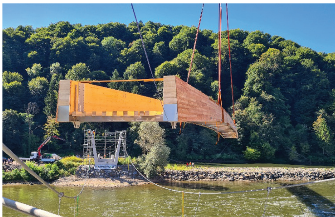
Slika 10, 11, 12, 13. Dvig in montaža mostne konstrukcije (31. 8. 2025).
