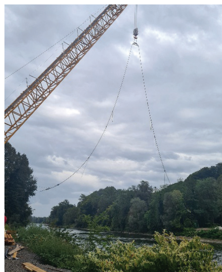
Slika 9. Montaža nosilnih vrvi.
