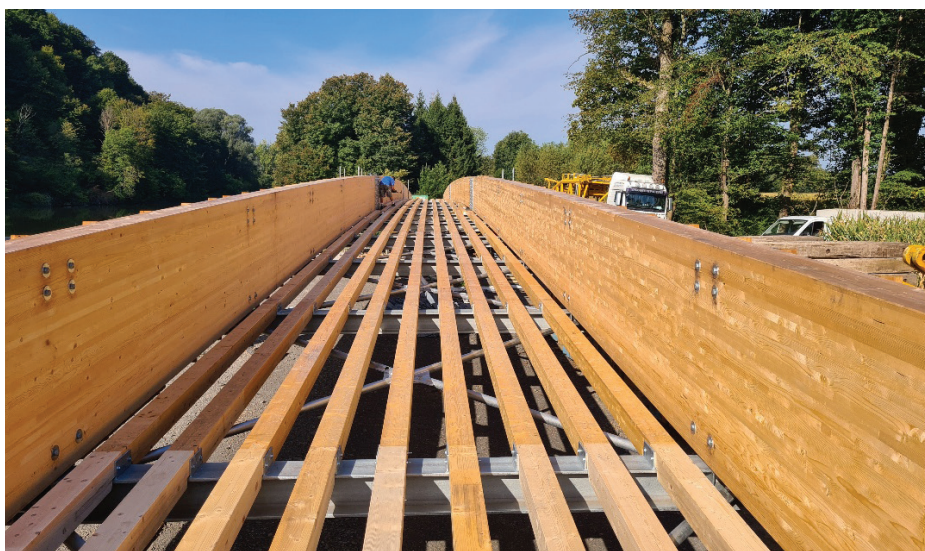
Slika 8. Montaža jeklenih prečnikov, vzdolžnikov in zunanjih opažev.
