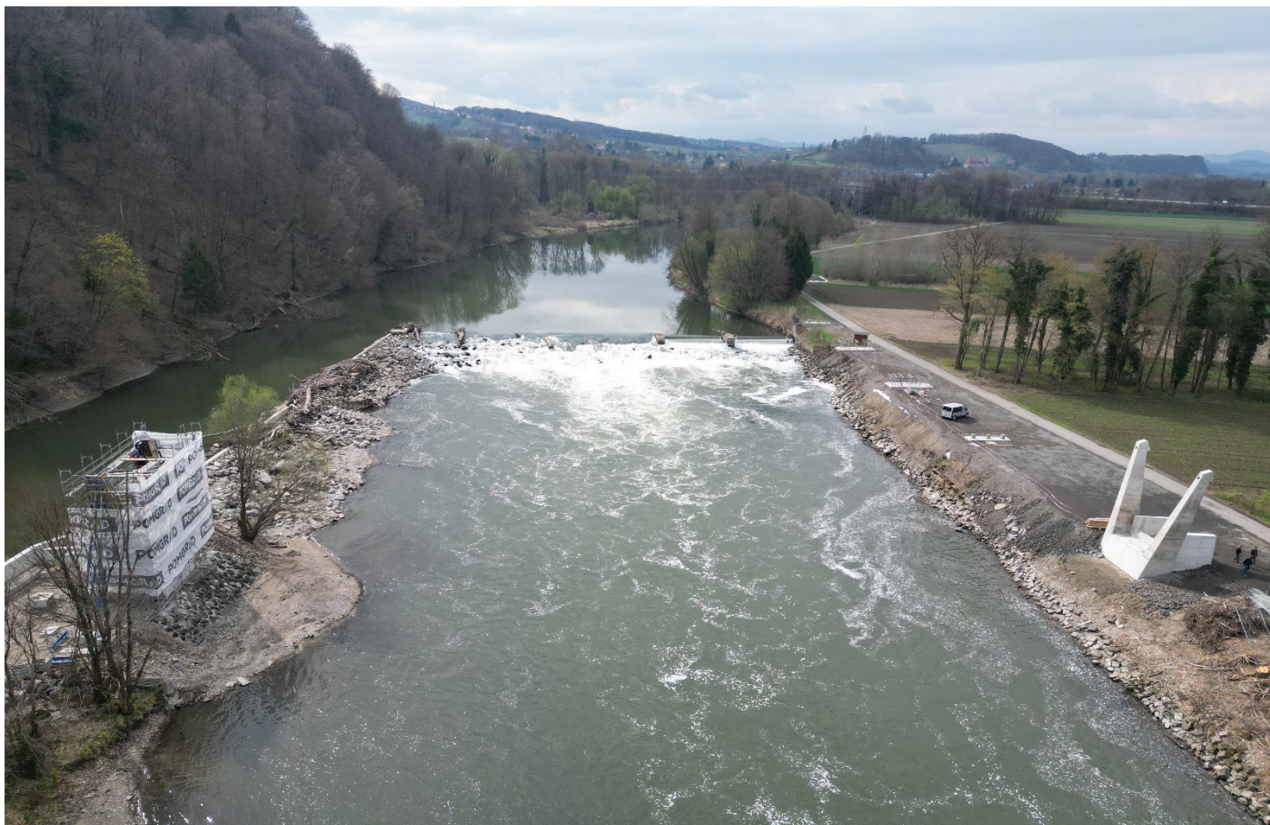
Slika 5. Zaopazen opornik (SLO) in izveden opornik (AUT), plato za montažo nosilcev (marec 2025).
