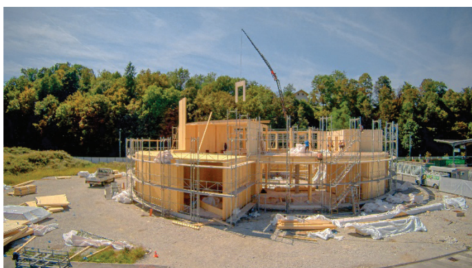
Slika 4. Izvedba 1. etaže (25. 8. 2025). Foto: Nejc Vurnik.
