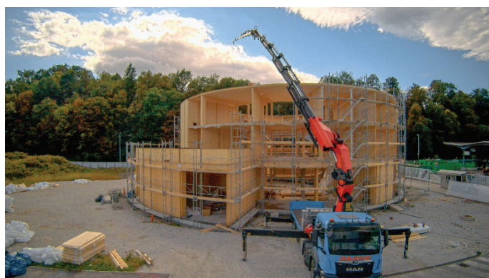
Slika 5. Zaključevanje zgornje, 2. etaže (1. 9. 2025). Foto: Nejc Vurnik.
