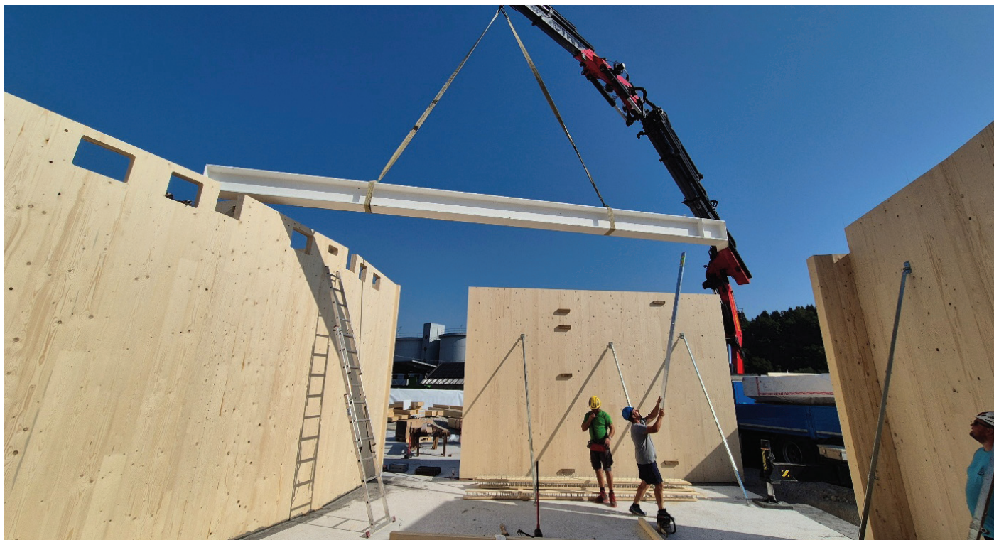
Slika 10. Montaža jeklenega nosilca na CLT-stene. Foto: Mitja Lalovič.
