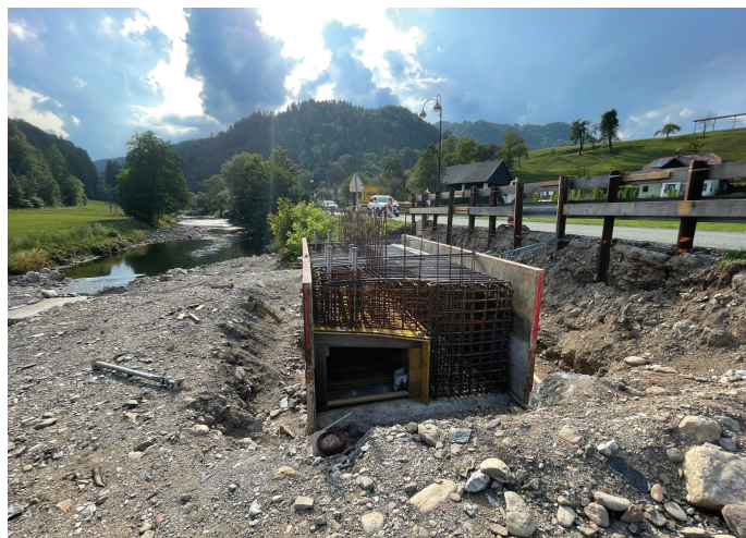
Slika 3. Gradnja AB krajnega opornika, avgust 2024.
