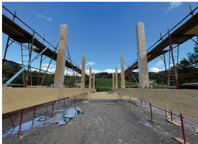
Slika 6. Sestava nosilne konstrukcije, oktober 2024.
