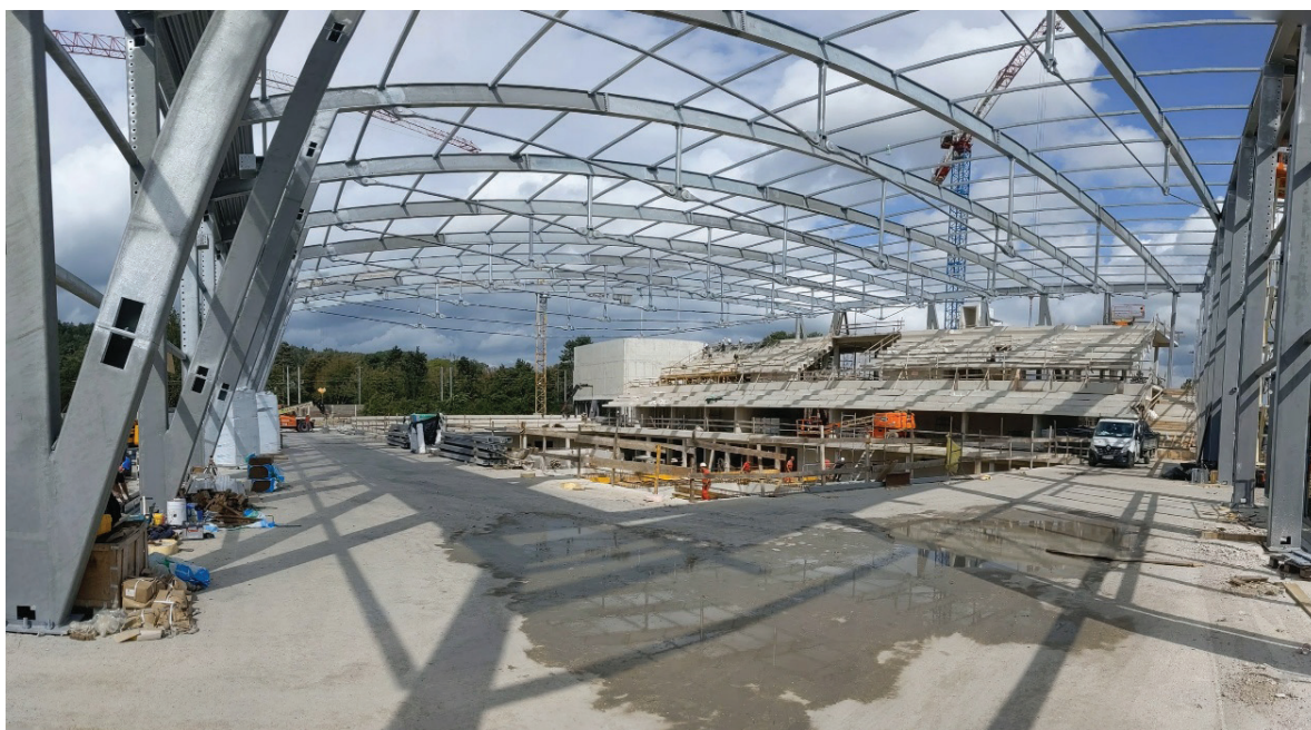
Slika 8. Pogled na glavno plavalno dvorano: Montaža tribun in jeklene konstrukcije kaže napredek tega pomembnega arhitekturnega in inženirskega dosežka. Skupaj se uporabi približno 1.500 ton jekla, ki se sestavi na kraju samem z uporabo vijčnih povezav. Celotna jeklena konstrukcija je vroče cinkana. (Foto: arhiv Elea iC, d. o. o.)
