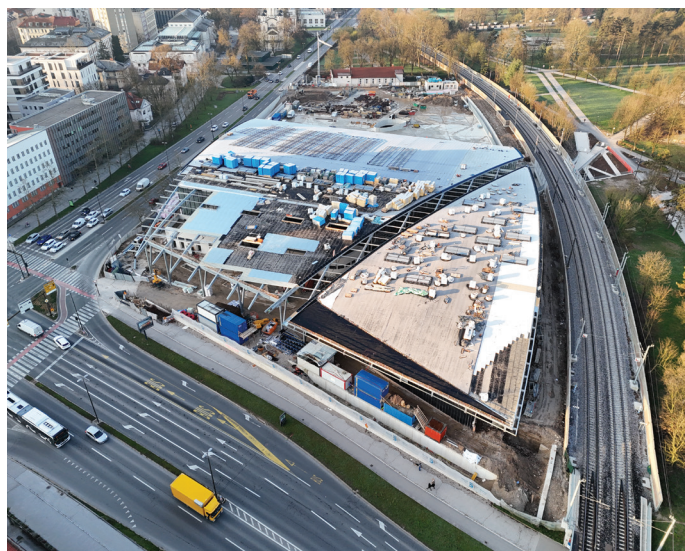
Slika 5. Marec 2024: Zaključi se jeklena strešna konstrukcija, začne se polaganje strešne kritine. (Foto: Aleš Dolenc, Elea iC, d. o. o.)
