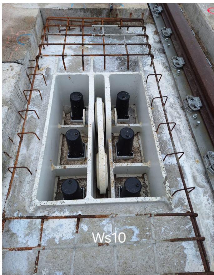
Slika 10. Zaključevanje sider z nameščanjem pokrov in injektiranjem prostih delov sidra z voskom (levo); preizkus funkcije priveza žerjava pred končno obdelavo površine območja tira (desno).
