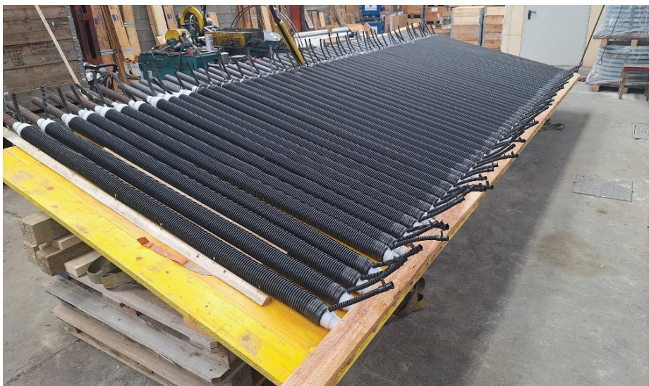
Slika 2. Sestava sidra v delavnici: levo – nameščanje distančnika za centriranje, desno – nameščanje zaščitne rebraste HDPE-cevi z oddušniki za injektiranje s cementno injekcijsko maso.
