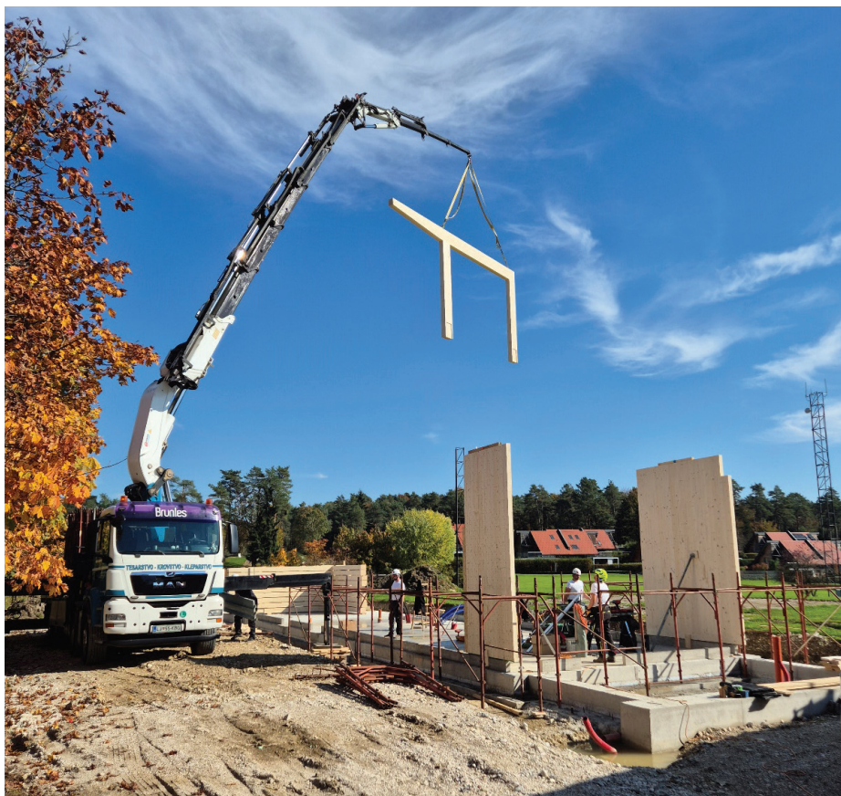
Slika 6. Montaža lesene konstrukcije okvirjev in sten.
