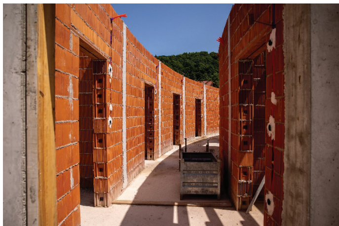
Slika 6. Opečne stene prvega nadstropja.
