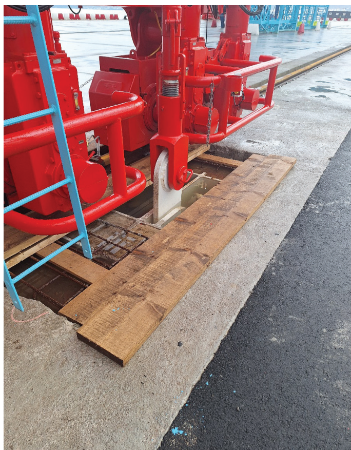
Slika 10. Zaključevanje sider z nameščanjem pokrov in injektiranjem prostih delov sidra z voskom (levo); preizkus funkcije priveza žerjava pred končno obdelavo površine območja tira (desno).
