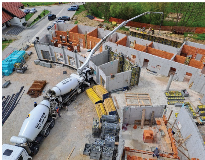
Slika 5. Faza betoniranja in zidanja notranjih sten.
