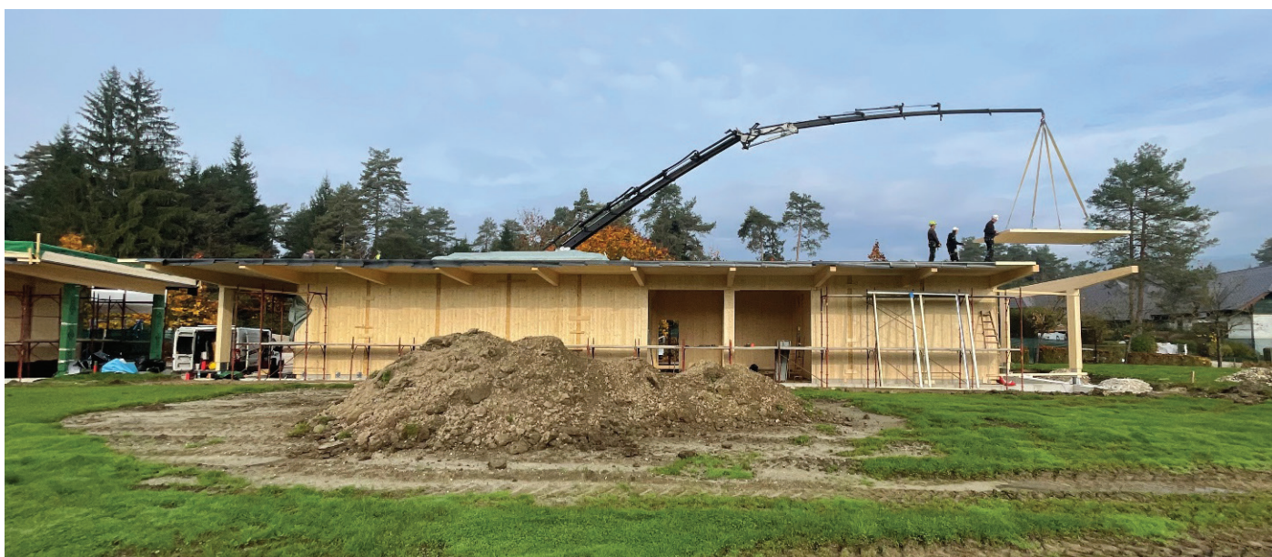
Slika 7. Montaža lesene konstrukcije strešnih elementov.
