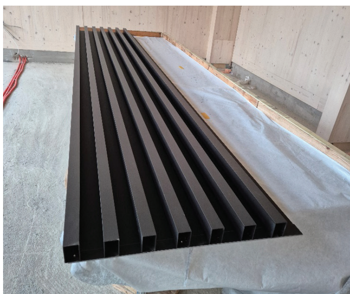
Slika 9. Panel ALU-fasade pripravljen za montažo.
