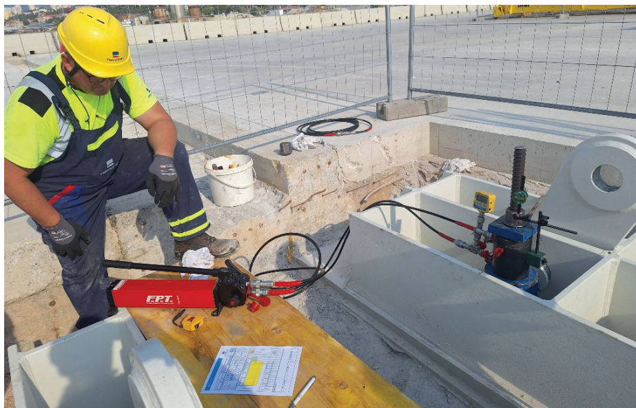
Slika 9. Napenjanje in testiranje sider.
