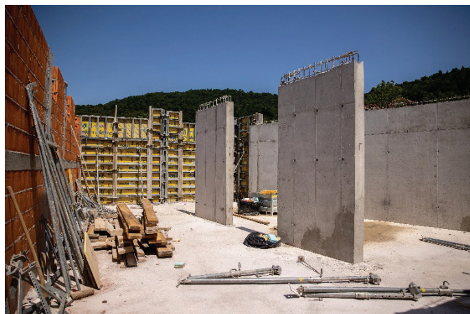
Slika 7. Armiranobetonske stene prvega nadstropja.
