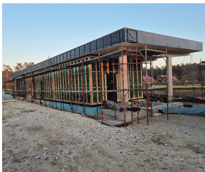
Slika 10. Podkonstrukcija prezračevane fasade.
