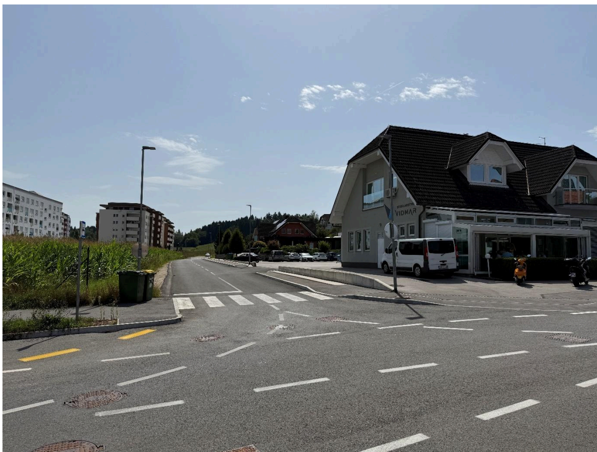
Slika 51: Urejena cesta (Na Dragah) do pilotnega območja Novo Mesto, OPPN za solesko Brod – Drage, EUP: NDS_04 (foto: Filip Živković, 2025)
