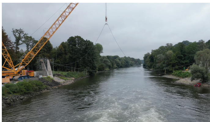
Slika 11. Montaža nosilnih vrvi
