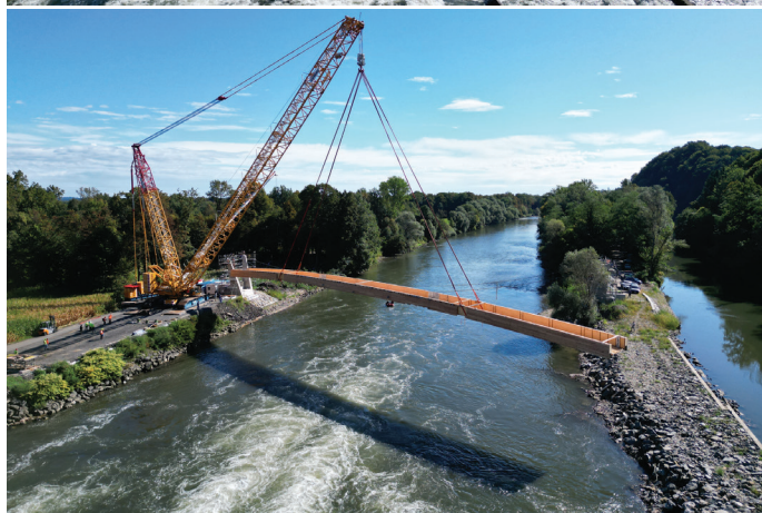
Slika 14. Montaža prekladne konstrukcije
