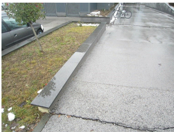
Slika 3. Poškodbe bližnjih voznih površin, ki se kažejo v obliki razpok in diferenčnih dvigov
