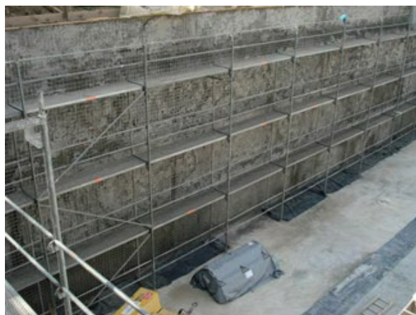
Slika 7. Armiranobetonska diafragma, izkopna dela v gradbeni jami in izravnava površin diafragme s slojem brizganega betona
