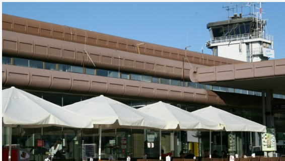
Ciril Oblak, razširitev vhodnega dela pristaniške stavbe Letališča Ljubljana, Brnik, 1991 (arhiv Cirila Oblaka)
