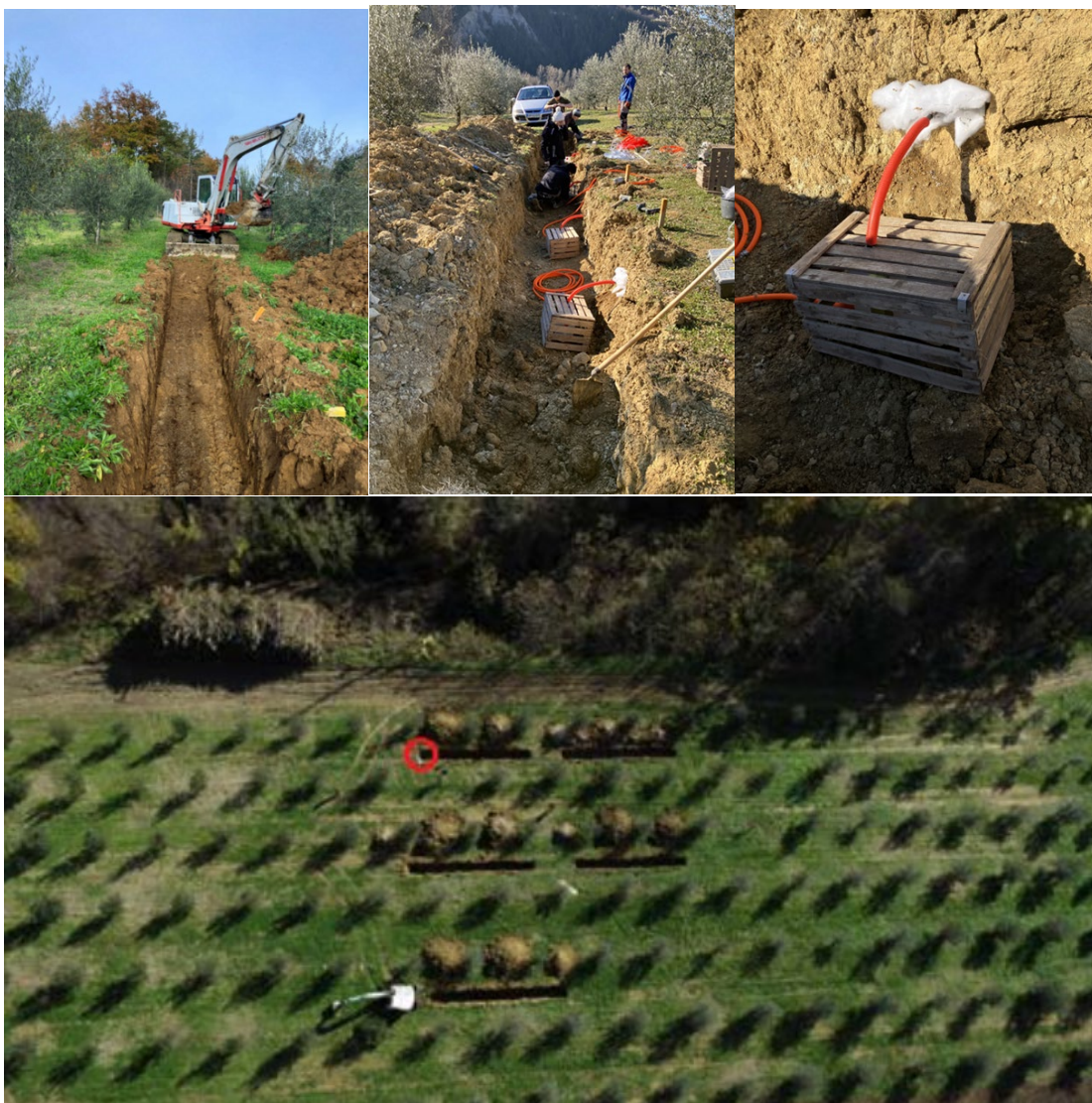
Slika 5: Vgradnja lizimetrov 7. 2. 2023.
