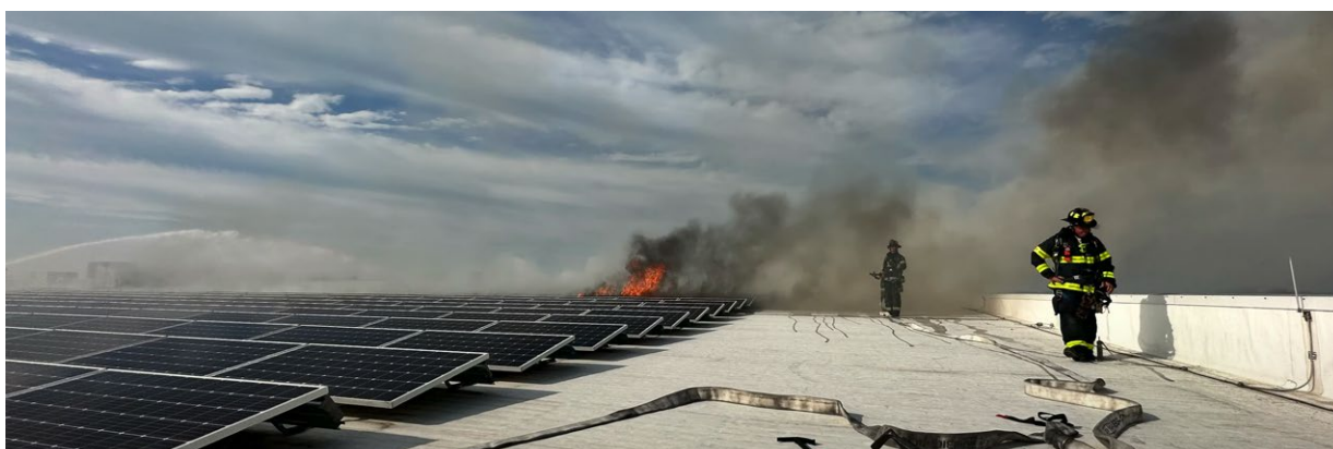
Imagen del incendio en la cubierta en Robbinsville, Nueva Jersey, EE. UU., con bomberos en acción
