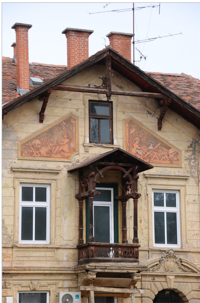
Derwuschkova hiša v Cankarjevi ulici 26a; detajl s personifikacijama Arhitekture in Gradbeništva (foto: Jakob Vidmar)
