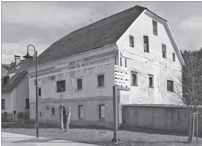
Pogled na pročelje Tavčarjevega dvora na Rečici (foto: Igor Sapač, 2025).
