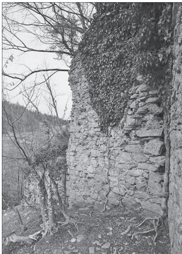
Pogled z zunanje strani na ostanek zahodne fasadne stene nekdanjega severozahodnega trakta severovzhodnega dela kompleksa gradu Rudenek (foto: Igor Sapač, 2024).
