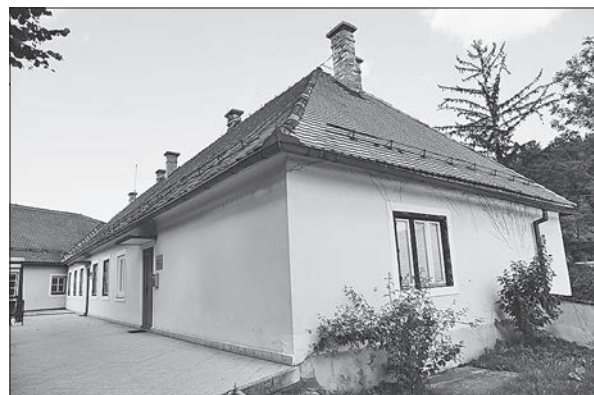
Po letu 1950 zgrajeno nadomestno prvo nadstropje leta 1944 razdejanega vzhodnega trakta (foto: Igor Sapač, 2016).
