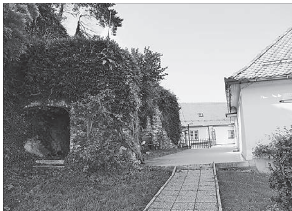
Ostanki leta 1944 pogorelega veznega trakta med grajskim jedrom in vzhodnim traktom kažejo za 18. stoletje značilno strukturo zidave v kombinaciji kamna in opeke (foto: Igor Sapač, 2016).
