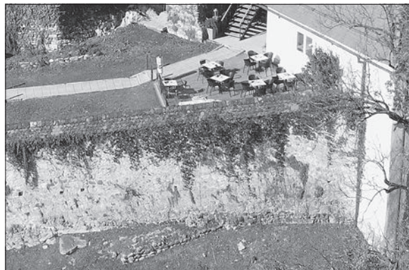
Pogled iz zraka na ostanek starejšega srednjeveškega zidovja, ki sega pod novoveško jugovzhodno stranico grajskega dvoriščnega obzidja in poteka vzporedno z jugovzhodno stranico romanskega obodnega zidovja grajskega jedra (foto: Nina Dominique Kumer, 2023).
