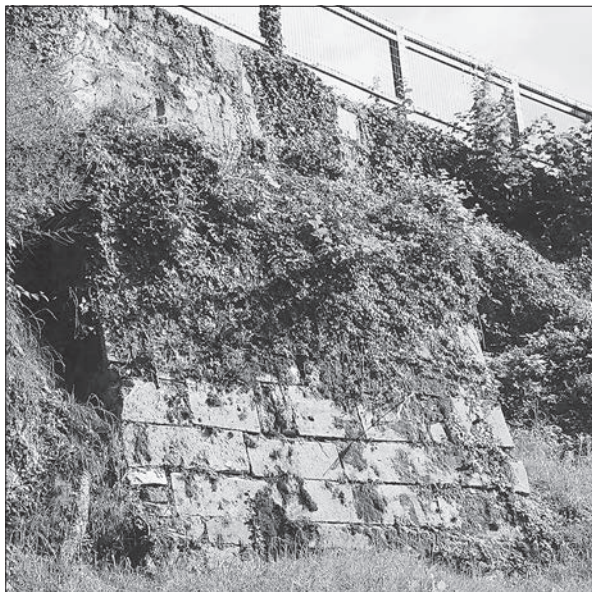
Ostanek renesančnega bočnega stolpiča na nekdanji severni fasadi grajskega jedra (foto: Igor Sapač, 2016).
