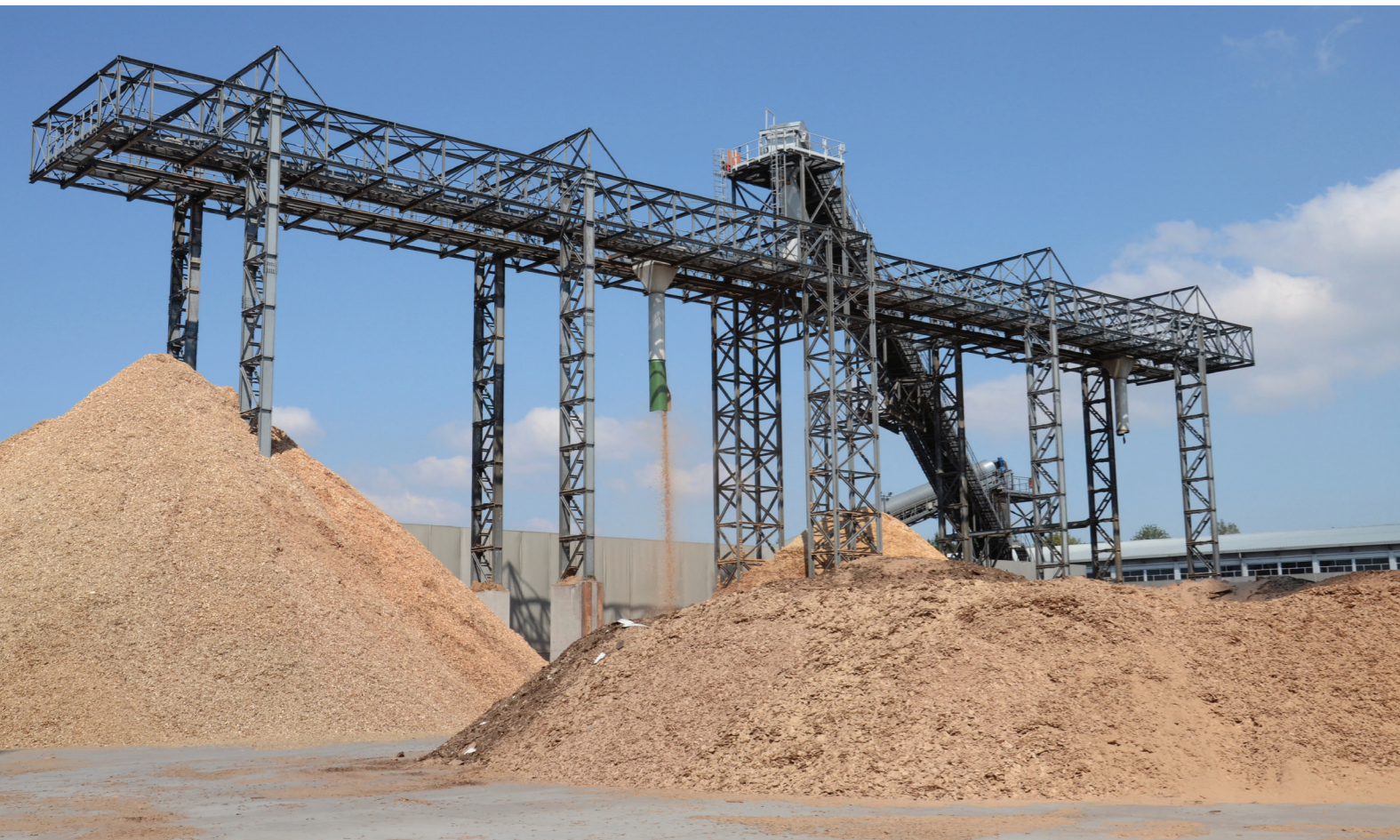
Slika 39: Skladišče lesnih sekancev za proizvodnjo vlaknenih plošč (Foto: Š. Ščap)
