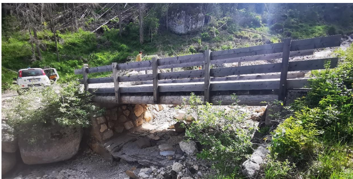
Slika 36: Izvedba mostu na gozdni cesti.
