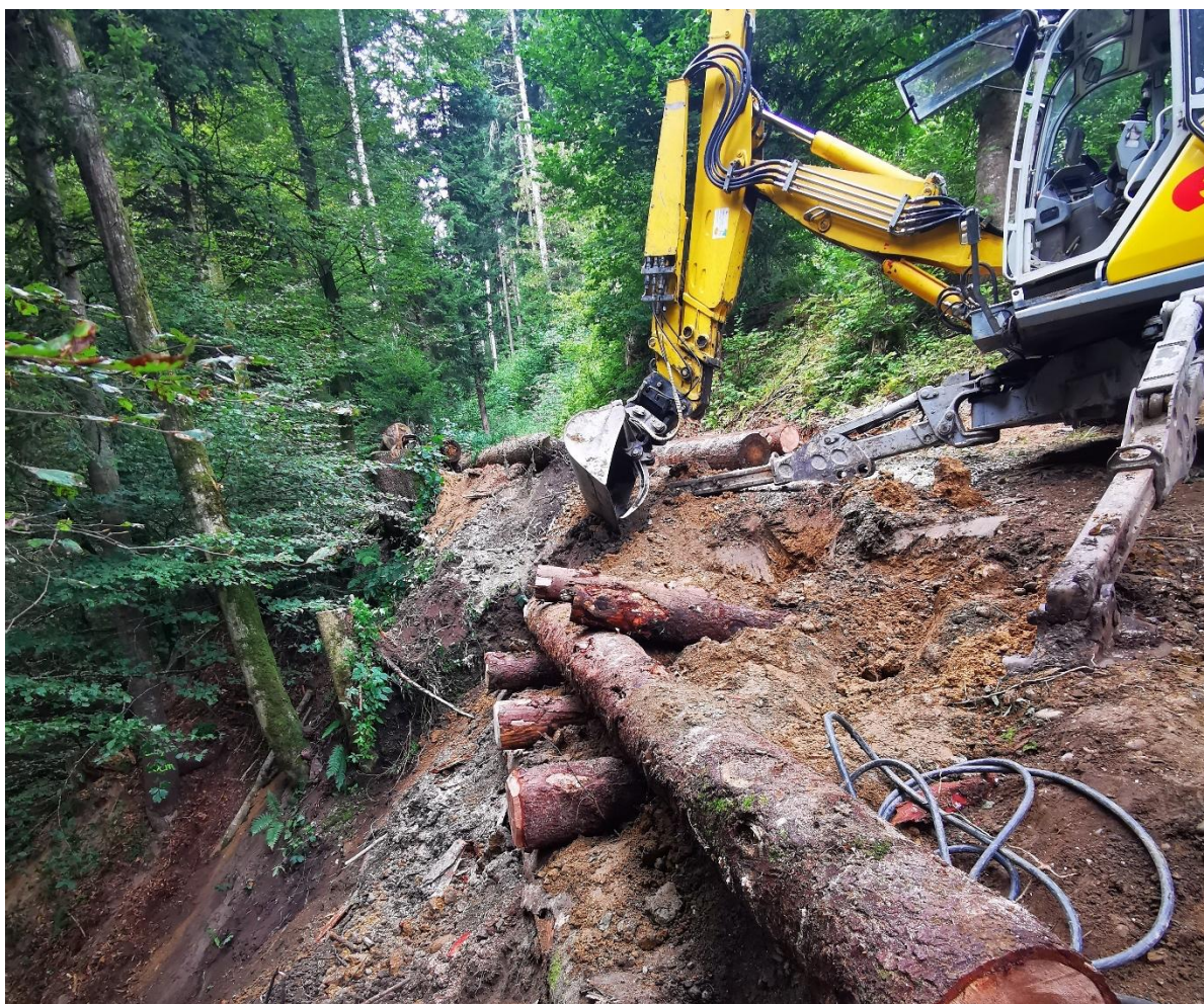
Slika 26: Izgradnja lesene kašte na gozdni cesti.
