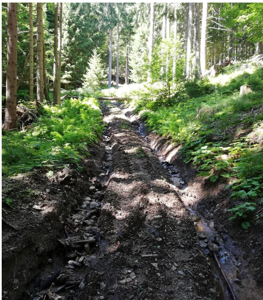
Slika 45: Vsak ki ima pravico uporabljati gozdne vlake jih ima pravico (po uporabi pa dolžnost) tudi vzdrževati. Zagotavljanje ustreznega odvodnjavanja in prevoznosti vlake sta ključni za dolgoročno zagotavljanje njene namenske rabe.
