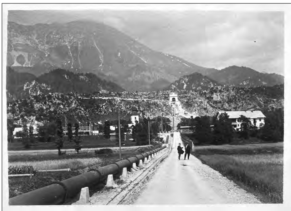
Železna cev in vodostan hidroelektrarne Završnica
