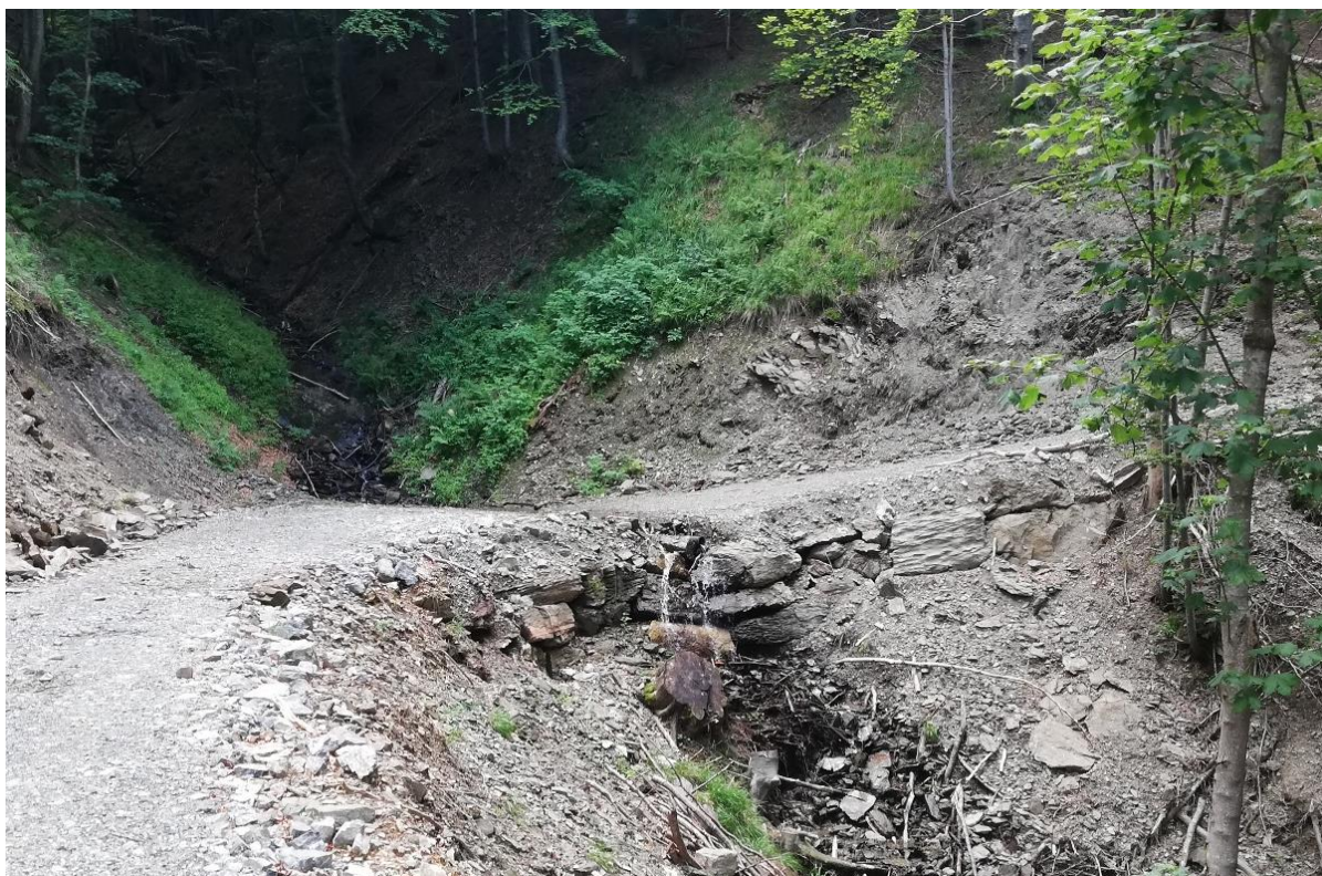
Slika 44: Mulda, podprta z večjimi skalami, vozišče je izdelano iz lokalnega materiala (Saražin J.)
