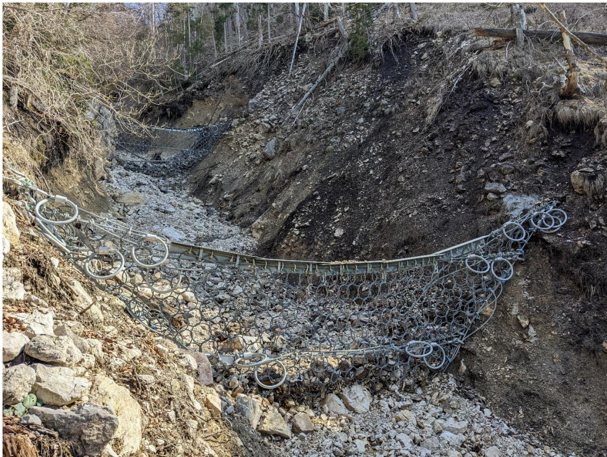
Slika 25: Mrežna hudourniška pregrada v Brezovškovem grabnu pod Krvavcem (Cej T.)
