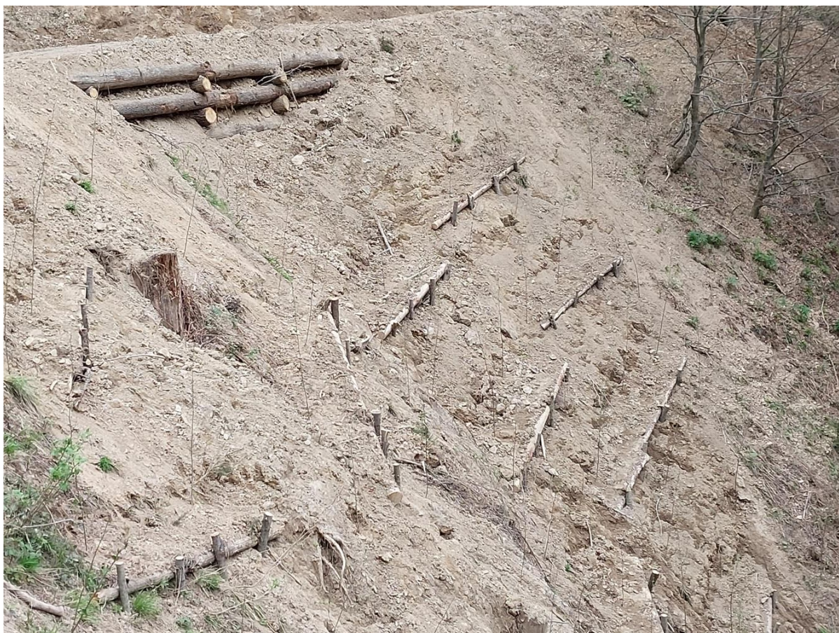
Slika 6: Sidranje sušic smreke za vrbove kole in panje (Škrlep B.)
