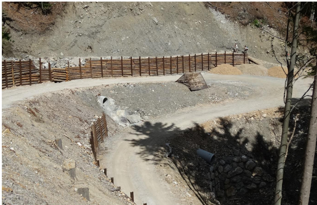
Slika 13: Lesene oblice so zložene za kovinske pilote na gozdni cesti na Jezerskem (Saražin J.)
