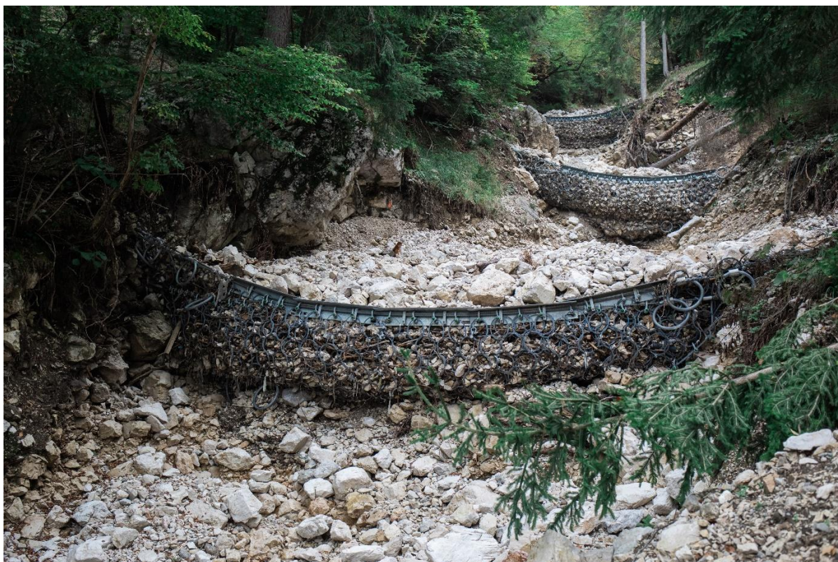
Slika 24: Sistem mrežnih hudourniških pregrad Geobrugg v Brezovškovem grabnu pod Krvavcem (Avanzo P.)
