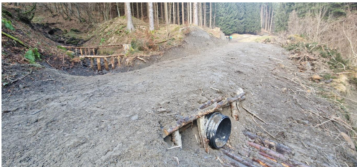
Slika 47: Cevni prepust s uvajalnimi prebiralnimi grabljami (Vilhar U.)
