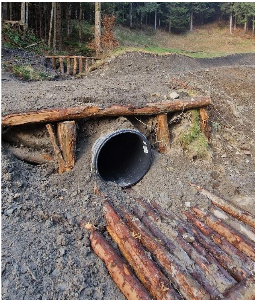
Slika 45: Cevni prepust z urejenim vtokom in iztokom z elementi iz lesenih oblic (Vilhar U.)
