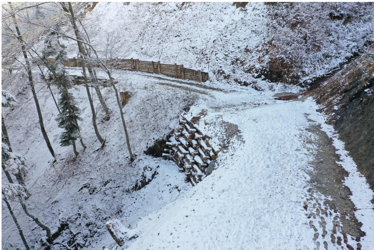
Slika 40: Betonska mulda na gozdni cesti podprta z leseno kašto (Saražin J.)
