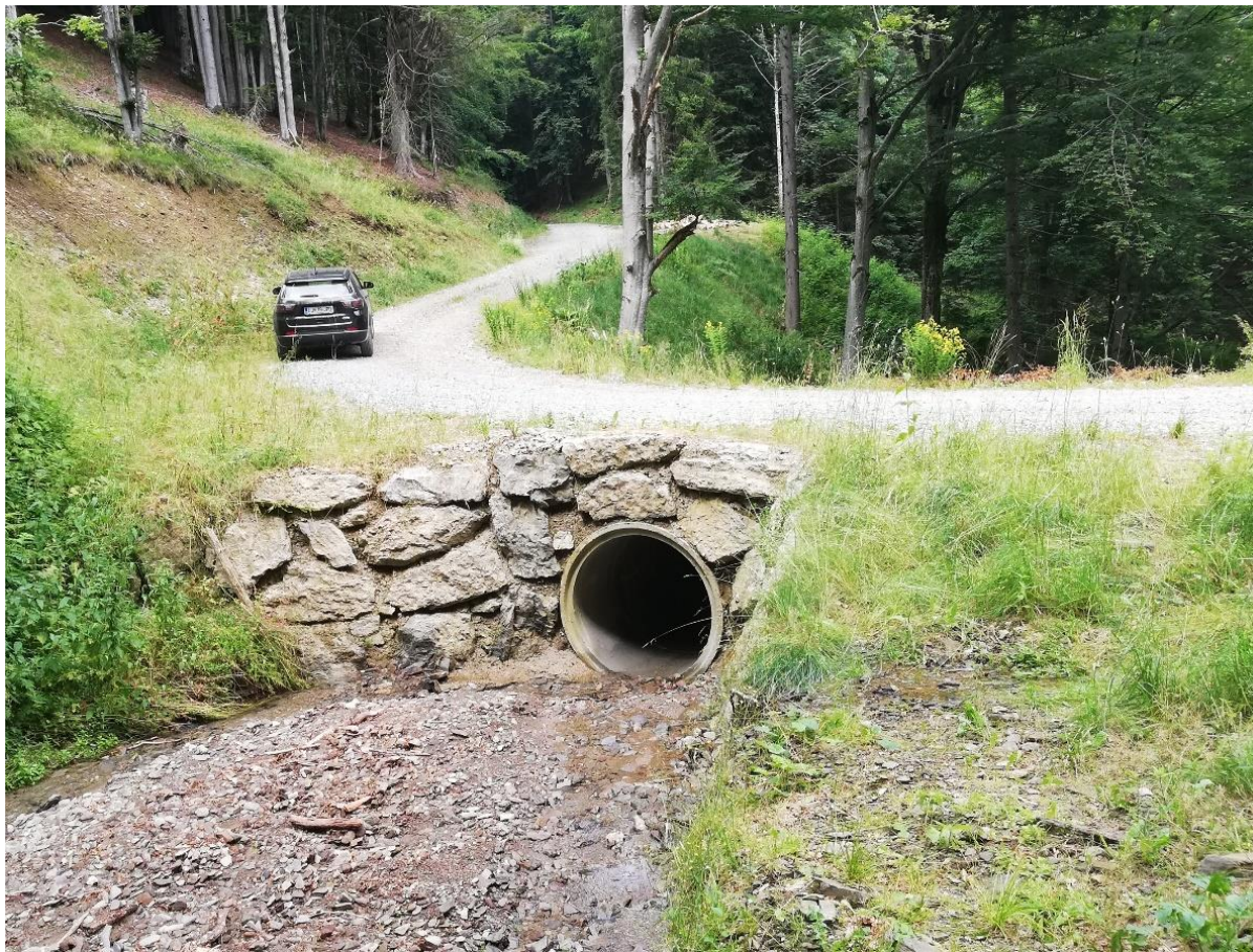
Slika 46: Cevni prepust z urejenim vtokom (Saražin J.)
