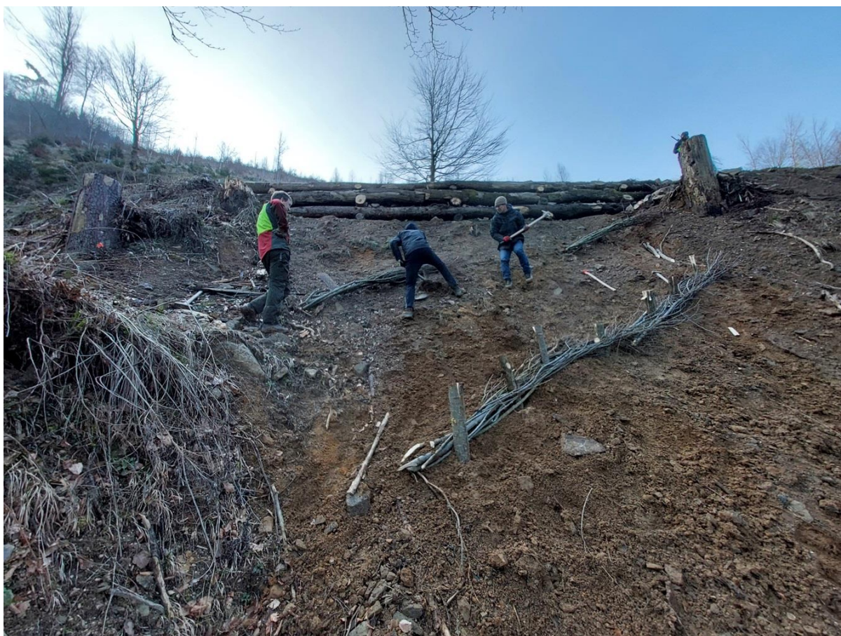
Slika 2: Delavnica izdelave fašin za zaposlene Zavoda za gozdove Slovenije na območju Železnikov (Škrlep B.)
