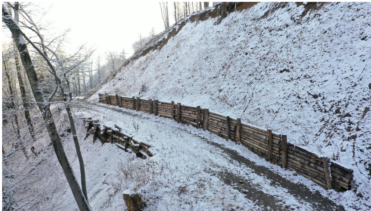
Slika 12: Zložba iz oblic nudi zaščito pred posipanjem odkopne brežine, medtem ko lesena kašta nudi tudi oporo vozni konstrukciji, na območju Železnikov (Saražin J.)
