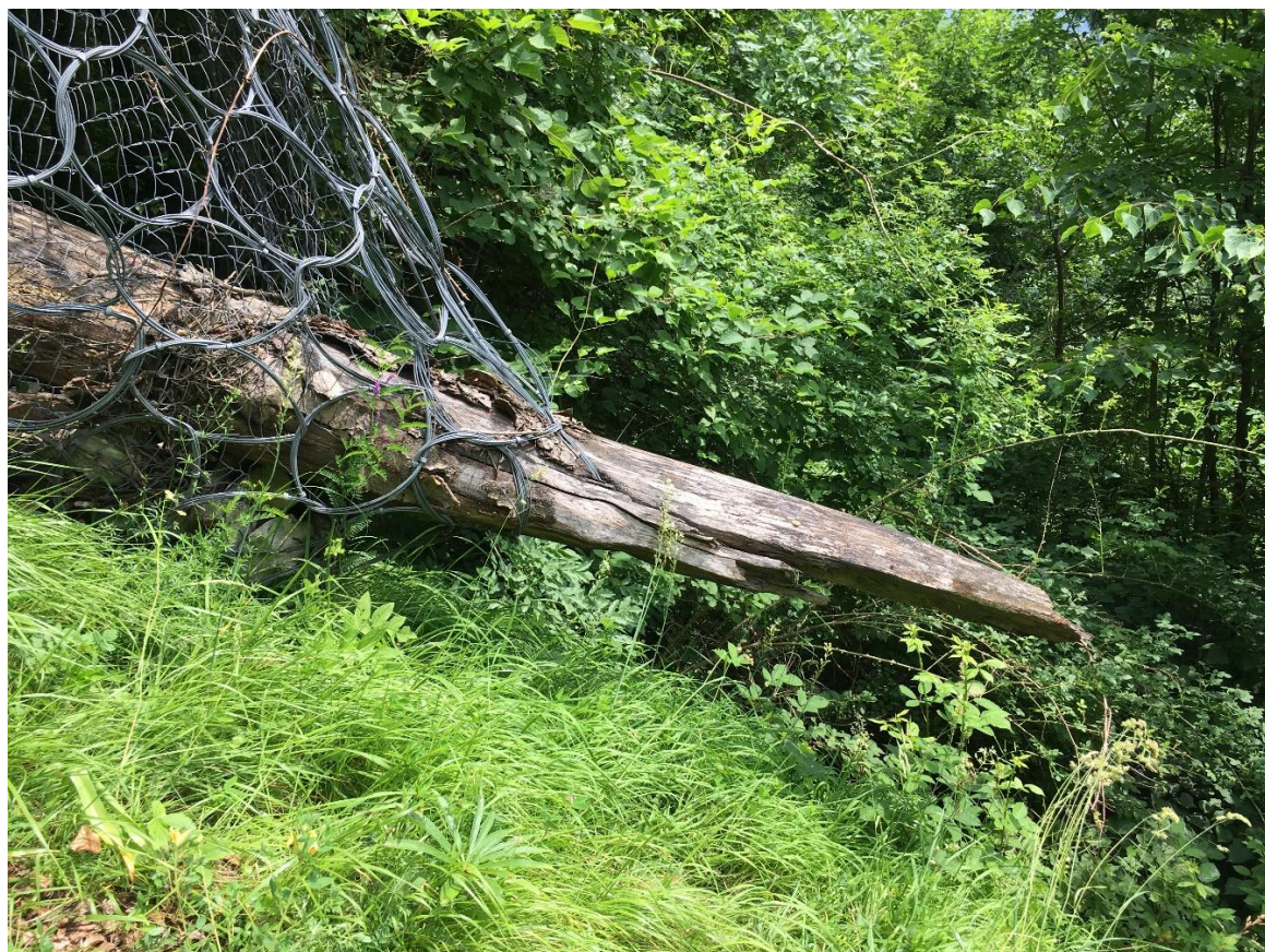
Slika 51: Podajno lovilni sistem Geobugg RXI-025 je uspešno ulovil večji hlod pri Železnikih (Cej T.)
