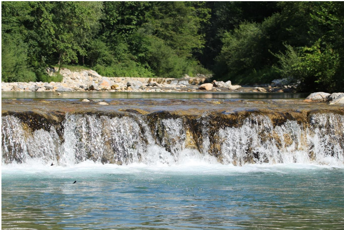
Slika 32: Prag iz kamna v betonu (Papež J.)
