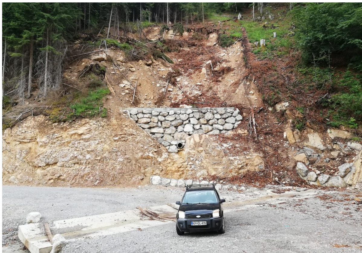
Slika 15: Kamen v betonu kot sanacijske rešitve erozijskega žarišča nad gozdno cesto na Jezerskem (Saražin J.)
