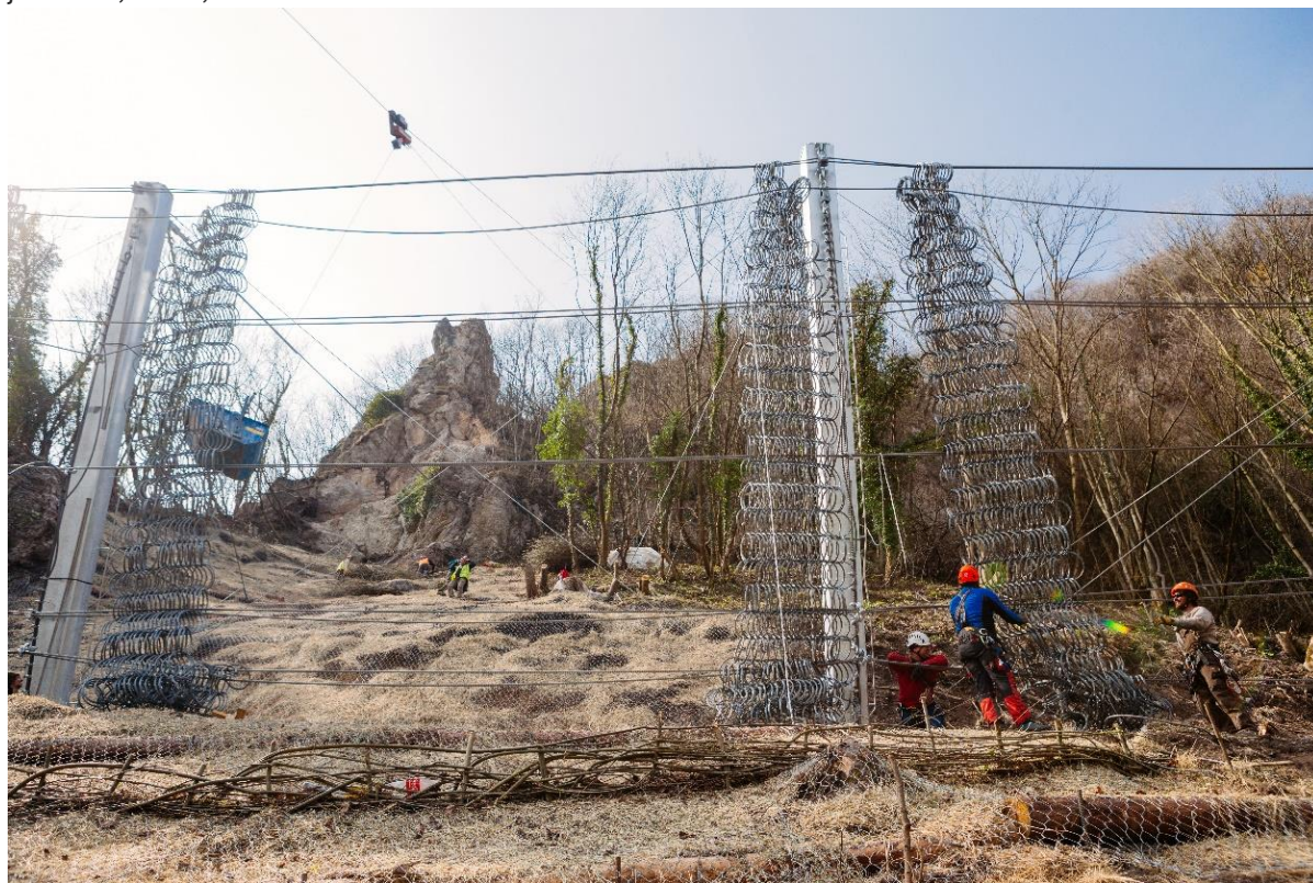
Slika 49: Podajno lovilni sistem Geobrug RXE-8000 nad tovarno Lafarge – Zagorje (Avanzo P.)
