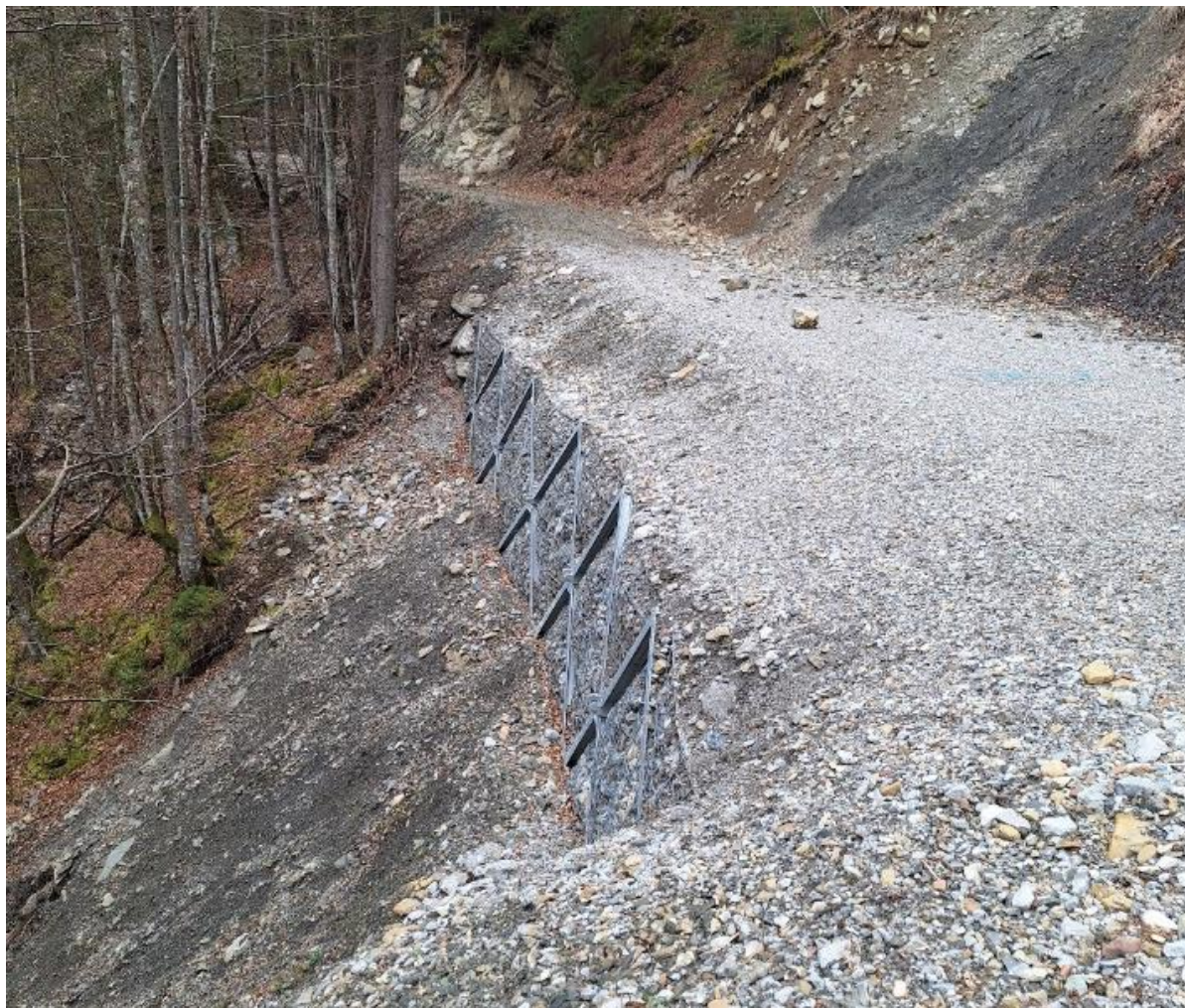
Slika 17: Mrežnati »dežniki« stabilizirajo nasipno brežino na gozdni cesti v bližini Beljaka (Pristovnik D.)
