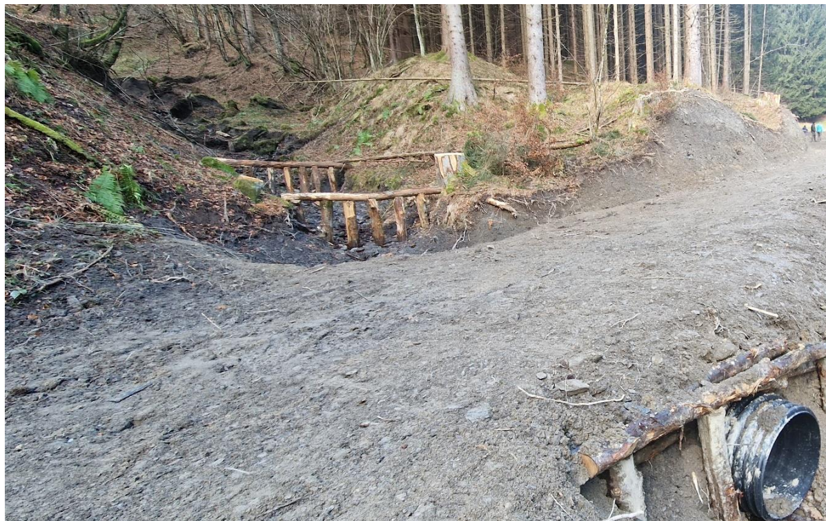
Slika 38: Sistem manjših prebiralnih grabelj pred cevnim prepustom (Vilhar U.)
