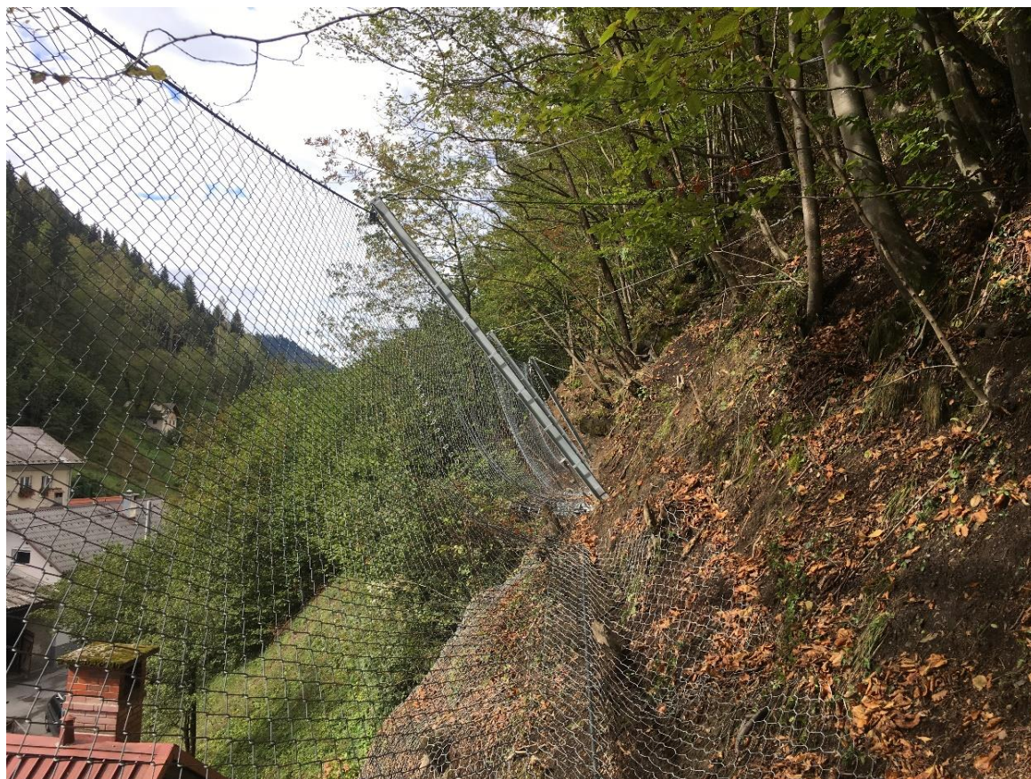
Slika 50: Podajno lovilni sistemi Geobugg GBE-1000A pri Podbrdu (Cej T.)
