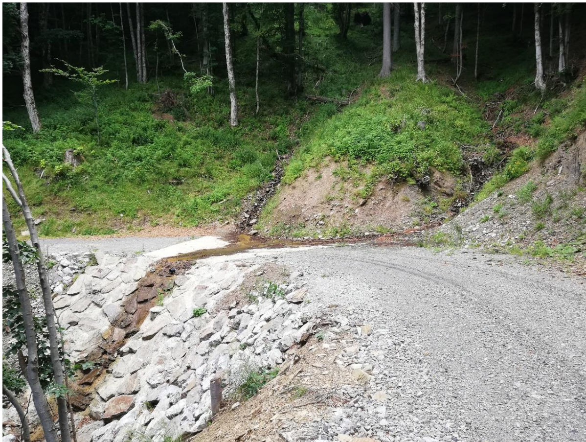
Slika 41: Utrjena mulda na gozdni cesti, podprta s kamnom v betonu (Saražin J.)
