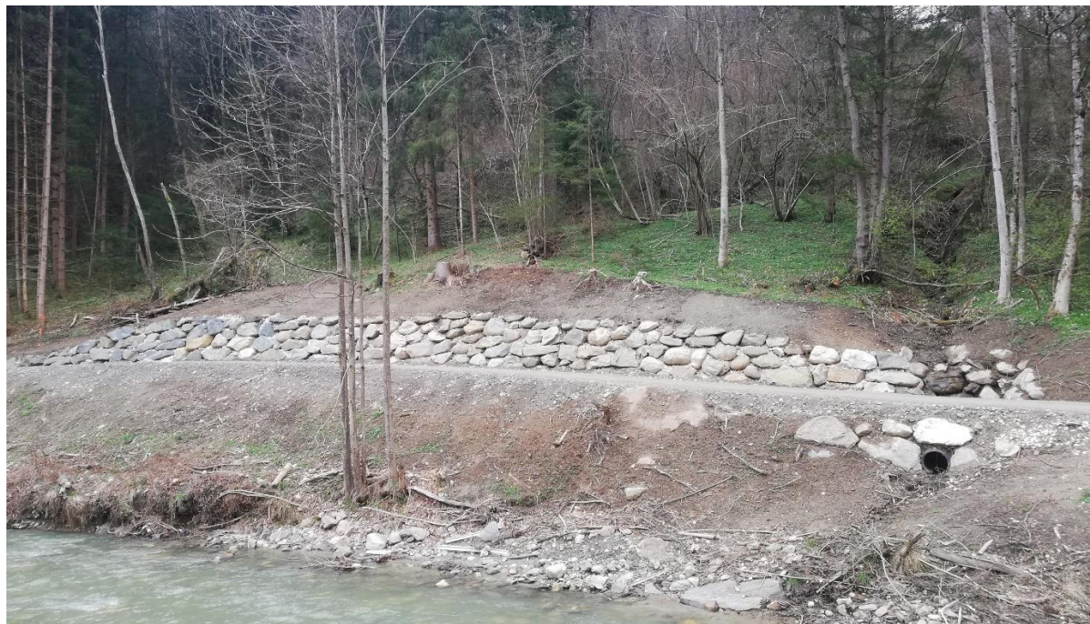
Slika 14: Zložba v suho na odkopni brežini gozdne ceste v okolici Beljaka (Saražin J.)
