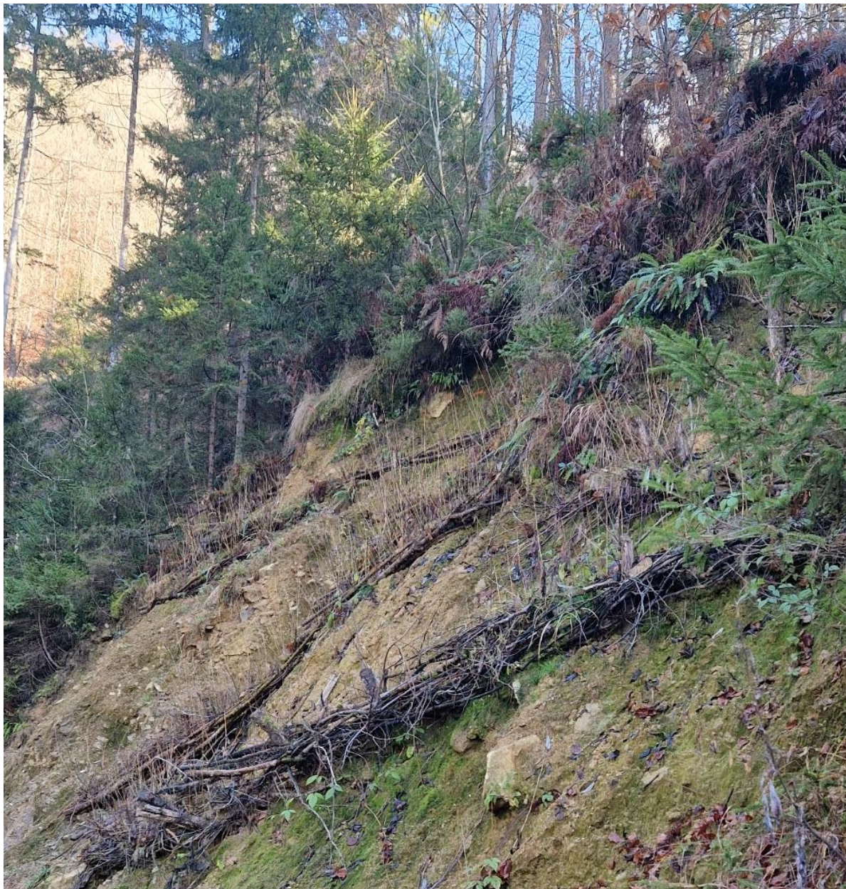
Slika 3: Vrbove fašine, sidrane s količki jelše, na območju Železnikov (Vilhar U.)
