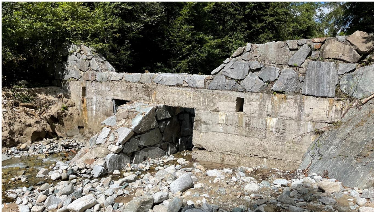
Slika 36: Prebiralna pregrada na Radoljni (Kobal M.)
