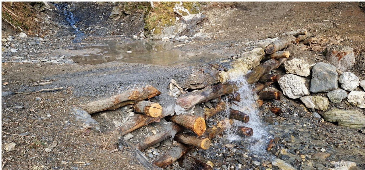
Slika 19: Lesena kašta omogoča prečkanje hudournika z gozdno vlako ( Vilhar U.)
