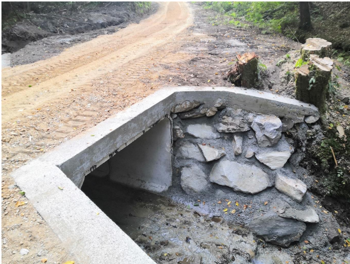
Slika 48: Škatlasti prepust na gozdni cesti z urejenim vtokom (Benčina A.)
