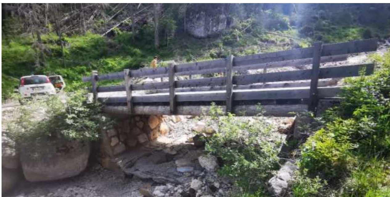
Slika 14: Izvedba mostu na gozdni cesti.
