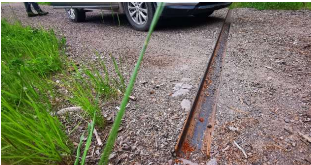
Slika 15: Za prečno odvodnjavanje uporabljajo kovinske dražnike.
