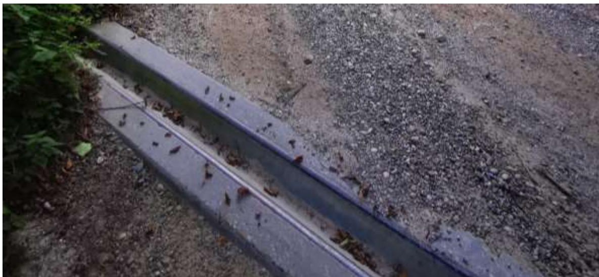
Slika 7: Vbetoniran dražnik v obliki črke V.
