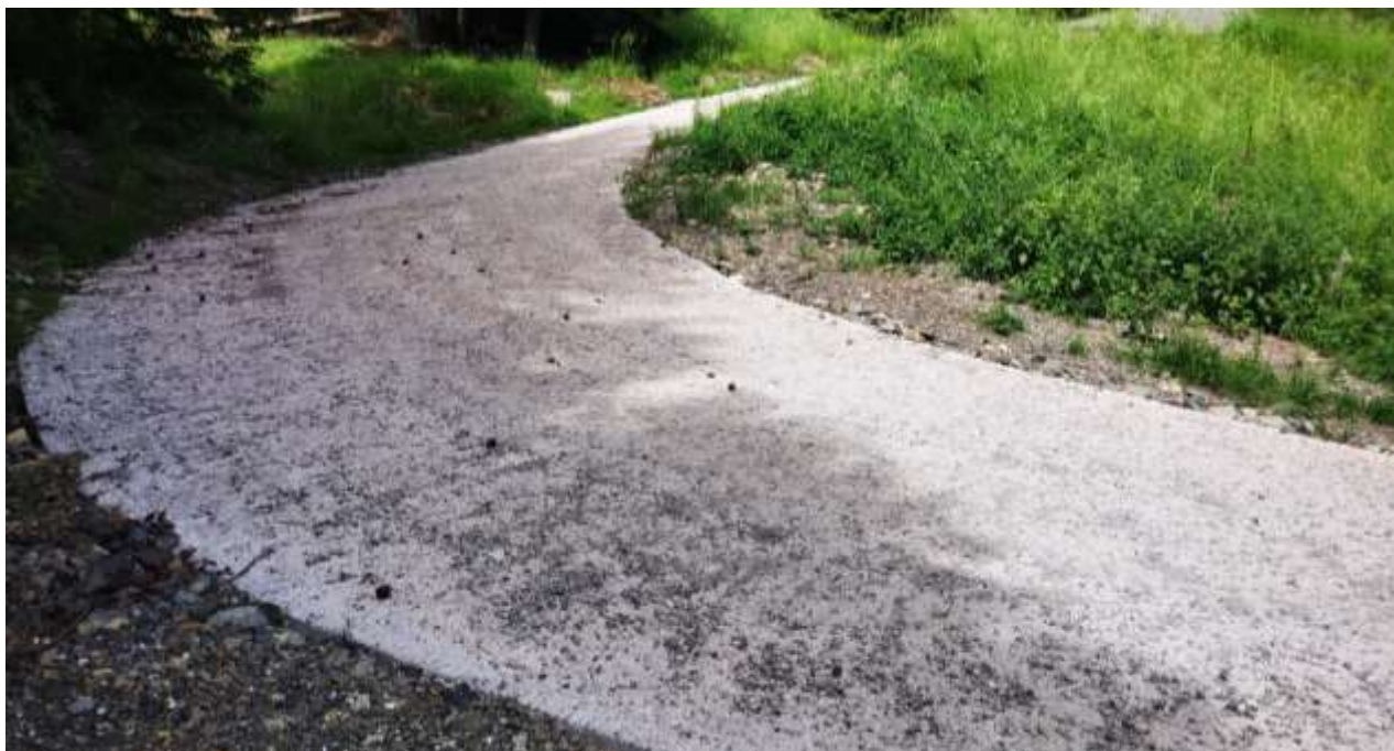
Slika 13: Betonska voziščna konstrukcija.
