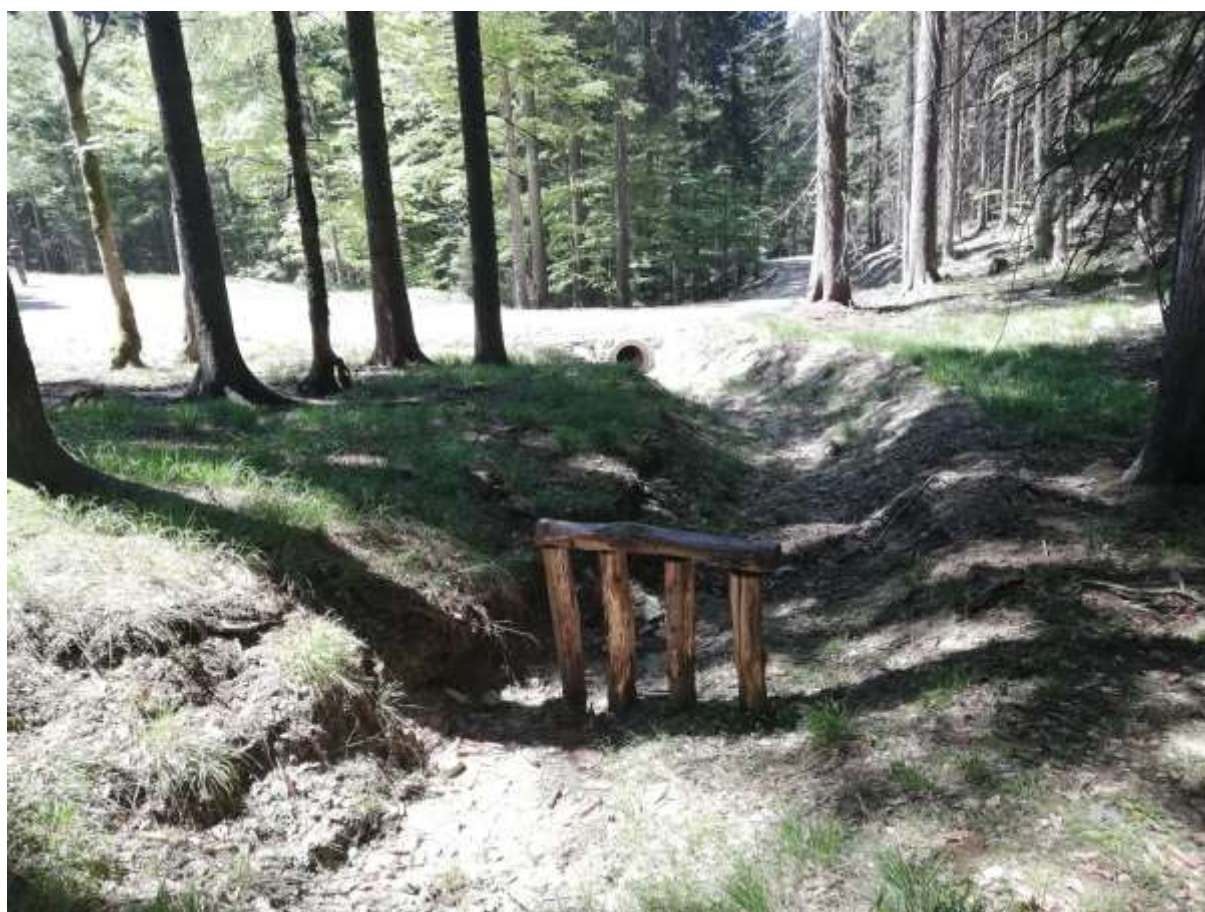
Slika 5: enostaven lovilni element nad cevnim prepustom gozdne ceste, namenjen prestrezanju plavja
