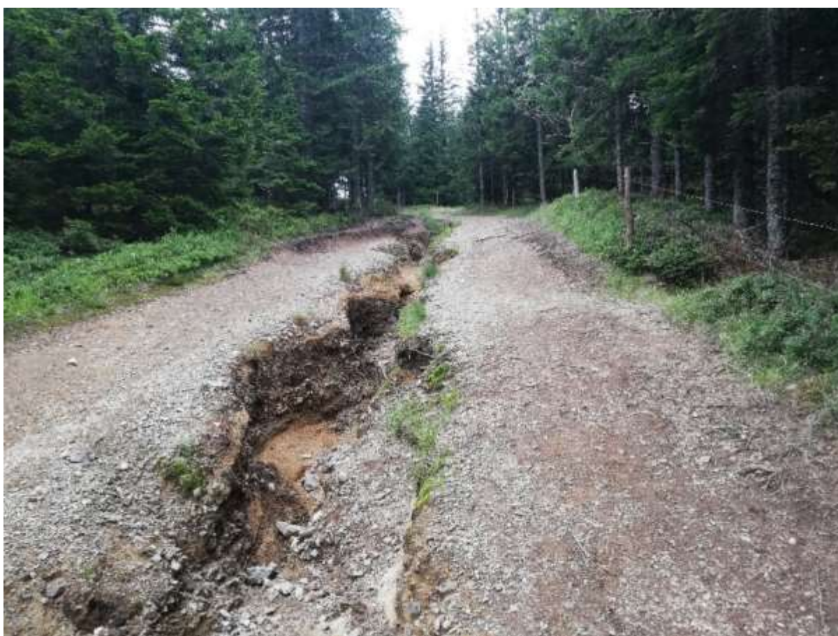
Slika 4: na močno erodibilnih podlagah so lahko že nizki nakloni problematični in je na njih potrebna umestitev prečnih jarkov
