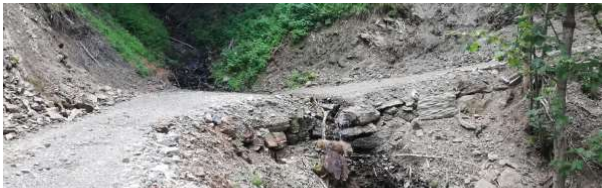
Slika 7: Mulda na gozdni vlaki
