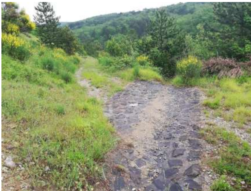
Slika 8: utrjena mulda na gozdni vlaki
