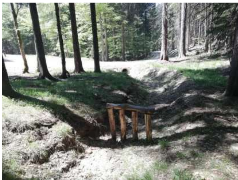
Slika 4: Primer manjšega prebiralnega objekta, ki služi zaščiti cevnega prepusta na gozdni cesti pod Rativcem (fotografija: Saražin J.)
