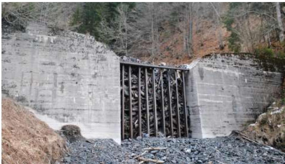
Slika 2: Polna prebiralna pregrada na hudouriku Suhelj (Turel, 2021)
