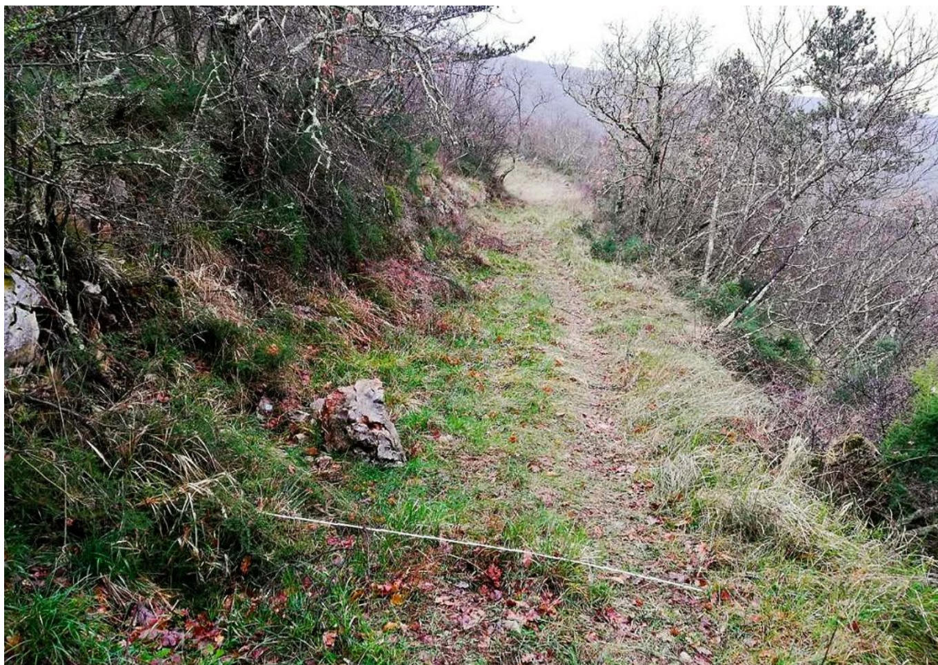
Slika 1: Gozdna vlaka, na kateri je nujno izvesti obsežnejša vzdrževalna dela, da bo zagotovljena njena namembnost in ustrezna erozijska odpornost. Ali vemo, kakšna je dopustna širina planuma, ciljni nakloni odkopnih brežin in potreba po prečnih jarkih? Ti odgovori se nahajajo v elaboratu gozdne vlake, ali pa o tem povprašajte predstavnika ZGS. (Foto: J. Saražin)
