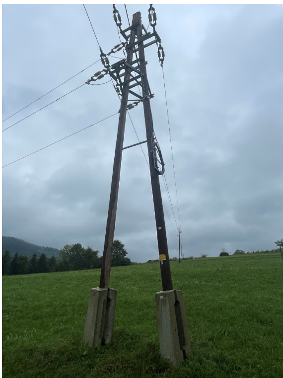
Slika 2: Daljnovidni drog A (levo) in vgradnja daljnovidnih drogov v betonske klešče (desno N drog)
