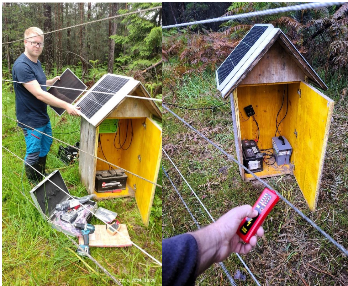
Slika 107: V maju je bila nameščena dodatna zaščita pred divjadjo z električnim pastirjem in montirane nove večje in zmogljivejše sončne celice za napajanje akumulatorja (levo). Septembra smo namestili nov močnejši aparat električni pastir. Napetost v trakovih ograje je bila konstantno maksimalna (desno). (Foto: M. Rupel)
