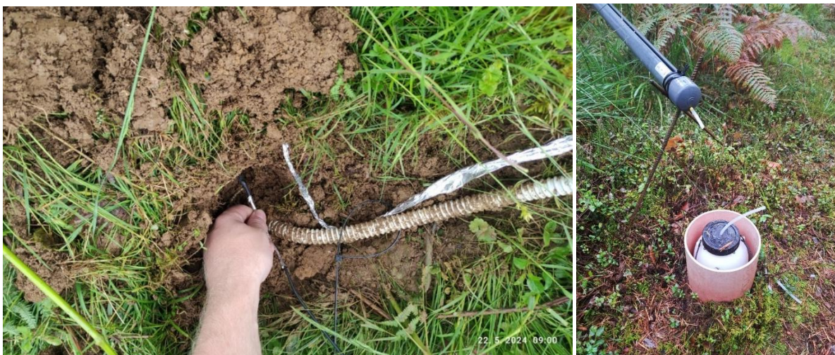
Slika 109: Pregriznjeni kabli talnih senzorjev na meteorološki postaji Brdo ter cevke žlebičev na ploskvi (Foto: M. Rupel)
