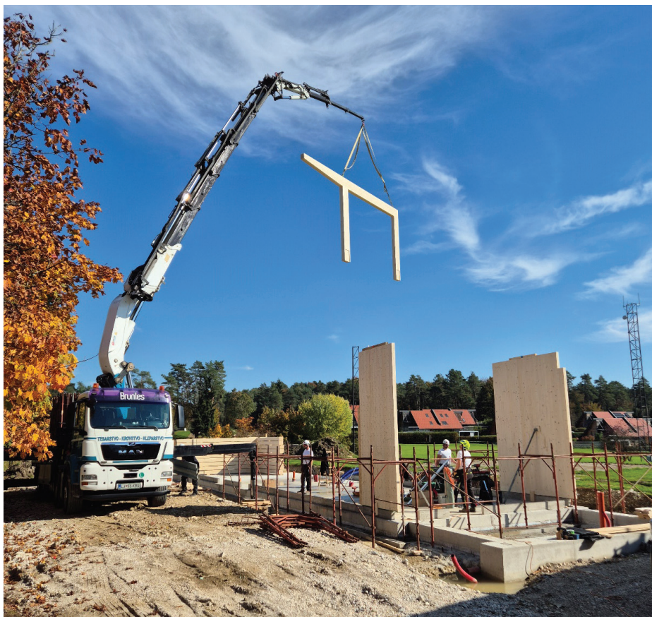
Slika 6. Montaža lesene konstrukcije okvirjev in sten.
