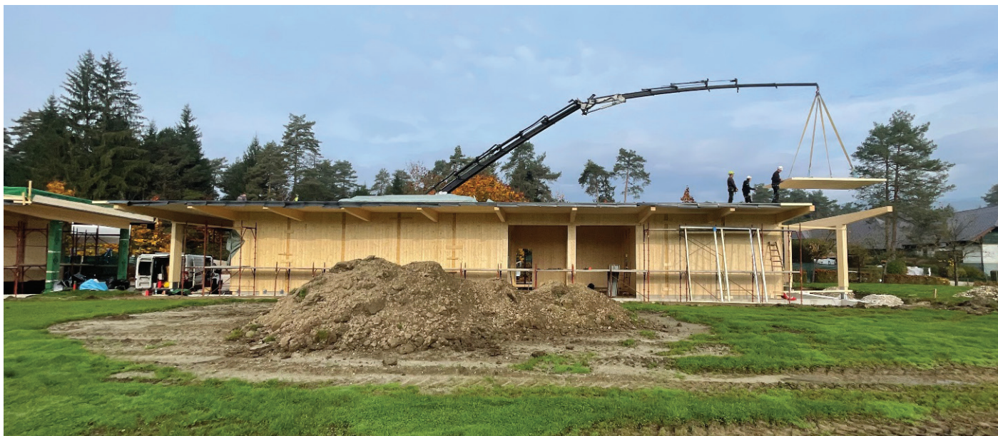
Slika 7. Montaža lesene konstrukcije strešnih elementov.
