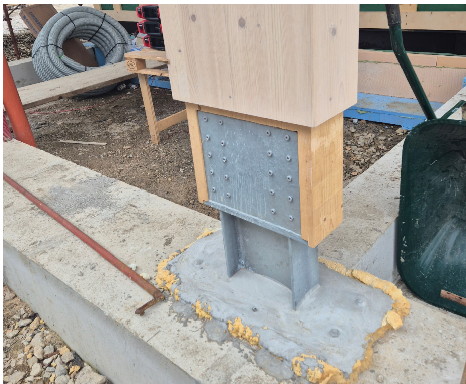
Slika 5. Detajl lesenega stebra okvirja zunaj.
