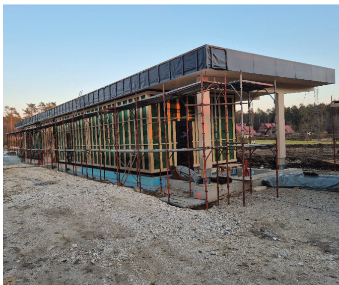
Slika 10. Podkonstrukcija prezračevane fasade.
