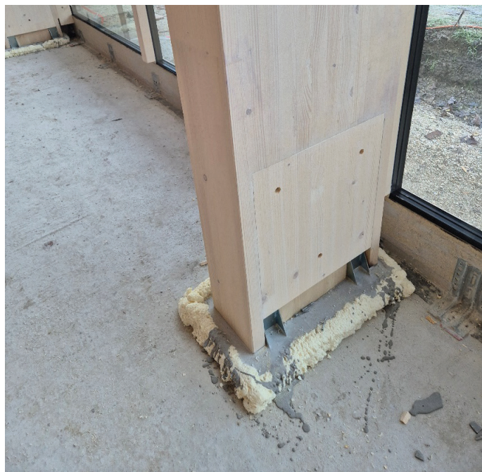
Slika 4. Momentni stik – sidranje lesenih okvirjev v AB-ploščo z nateznimi sidrnimi elementi nosilnosti preko 100 kN/sidro, naknadno spdlito z nabrekajočo malto z dodatkom Kema Expand.
