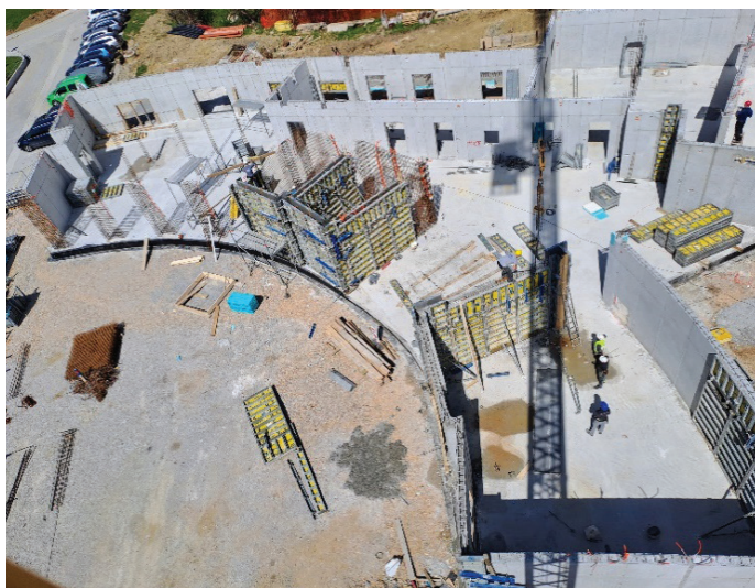
Slika 4. Zgodnja faza gradnje s pripravljenimi opaži in izvedenimi armiranobetonskimi stenami.
