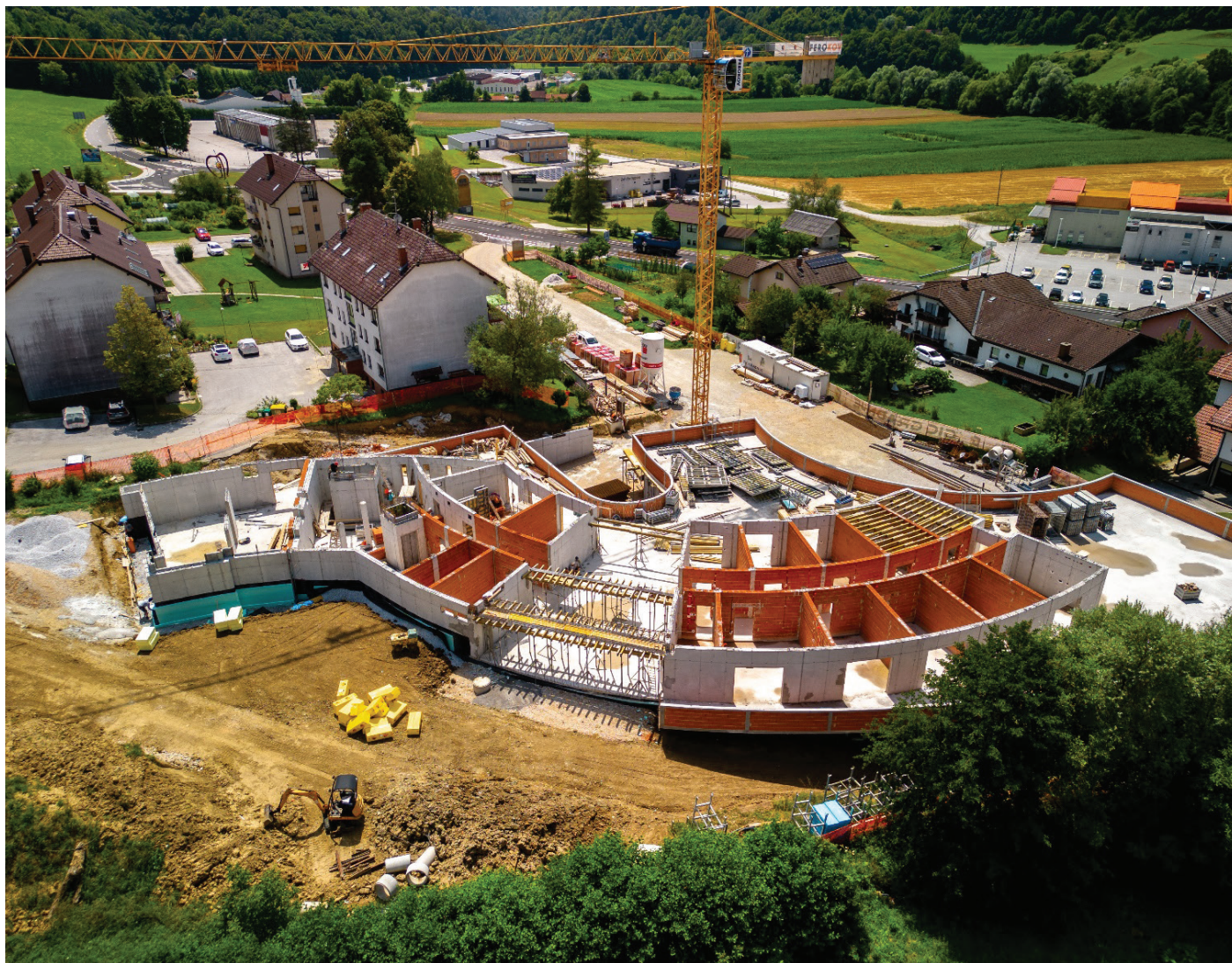
Slika 1. Zaobljena struktura objekta z betonskimi in opečnimi elementi.
