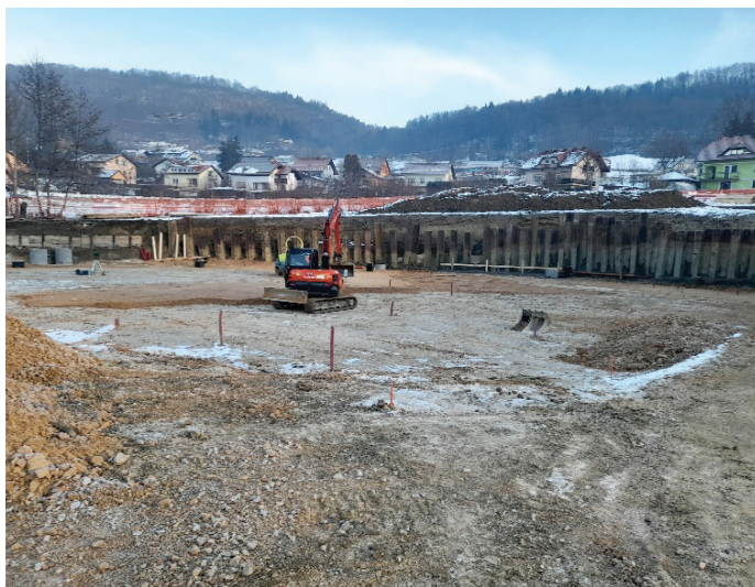
Slika 2. Začetna faza gradnje s pripravo terena in izkopi ob podporni steni.
