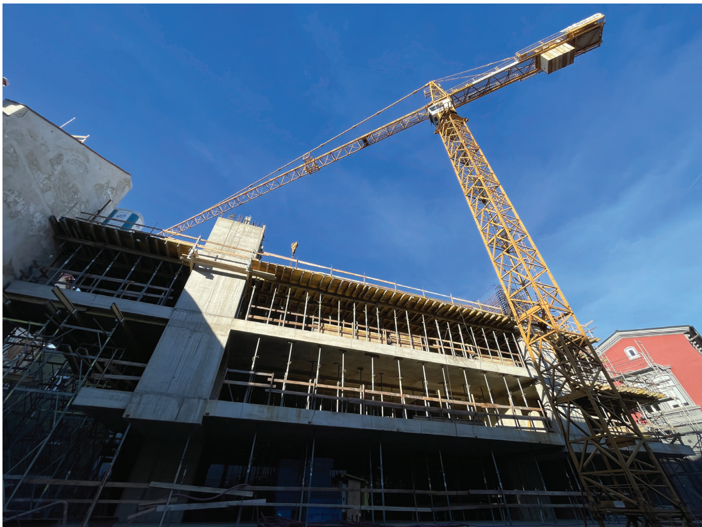
Slika 2. Gradbena dela na novi Mariborski knjižnici (25. 11. 2024).
