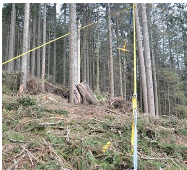
Varovanje (sidranje) opore (drevesa) čevlja.
