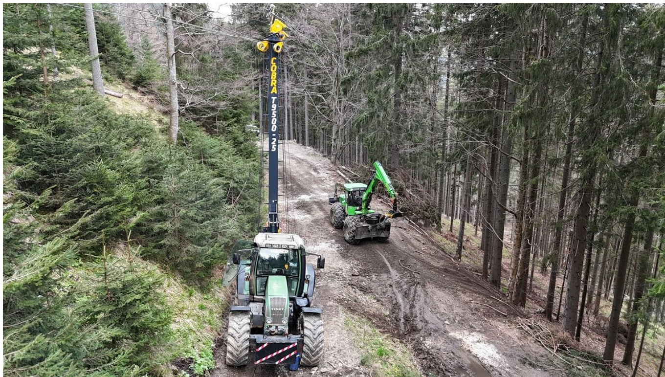
Slika 5: Mehanizacija na delovišču.
