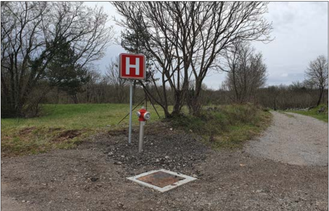
Slika 4: Kraški vodovod je v Občini Sežana zgradil šest namenskih hidrantov za varstvo pred požari, načrtuje pa izgradnjo še dveh hidrantov. Od navadnih hidrantov se ločijo tako, da omogočajo dobavo več požarne vode brez negativnih učinkov na vodovodno omrežje (foto: M Kravanja).
