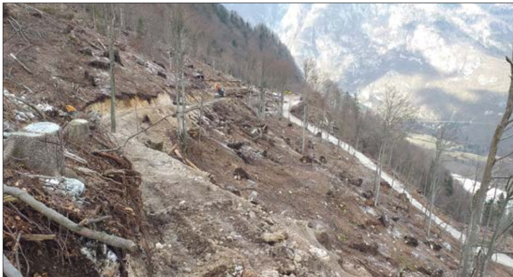
Slika 7: Končano delovišče 8/1 Konec ceste in gradnja nadaljevanja gozdne ceste Peščenik–Čisto Brdo, februar 2024 (foto: D. Marković)
