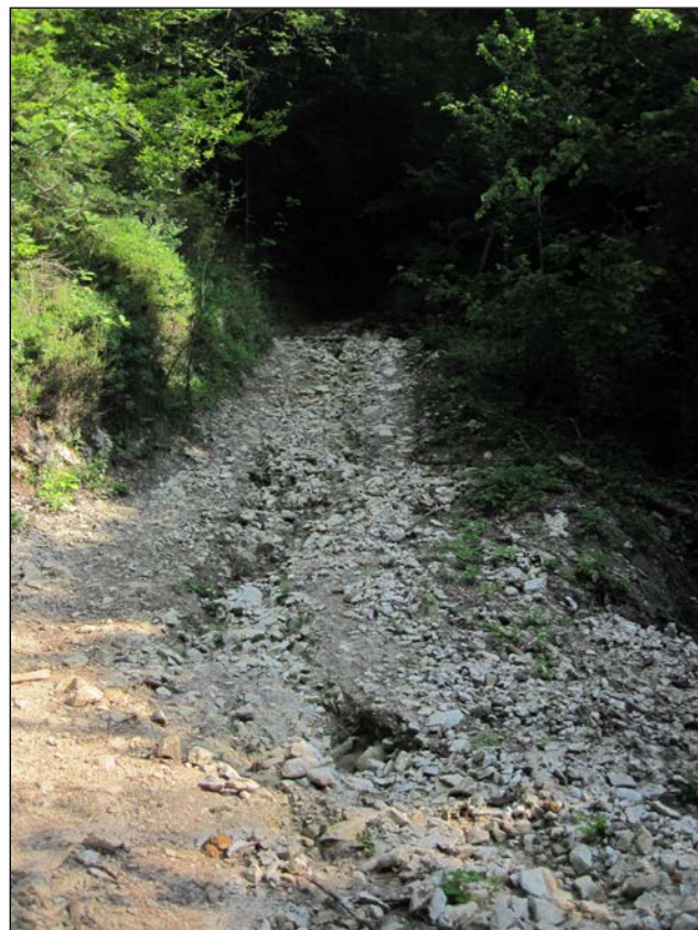
Slika 29: Zmanjšani prečni profil potoka (levo) je povzročil sipki material, ki ga je odneslo z gozdne ceste (desno) (Savski potok, 15. 7. 2015; foto: M. Govedič).
