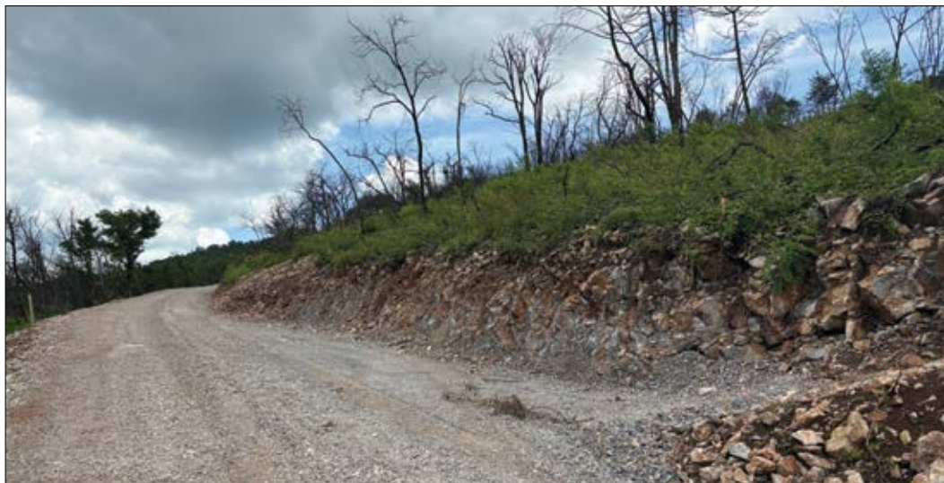
Slika 2: Z minimalno štirimetrsko širino gramoznega vozišča (brez bankine), obračališči in utrjenimi izogibališča gozdna cesta Volkovnjak ustreza uporabi sodobne gasilke opreme
