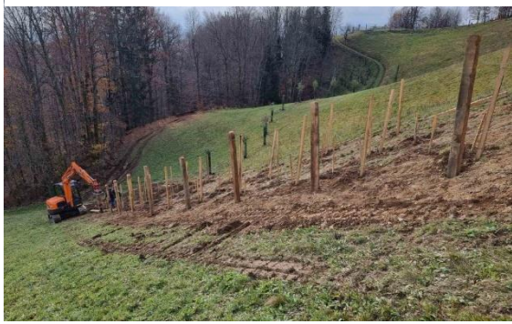
Slika 27: Mehansko izvajanje pripravljajnih del
