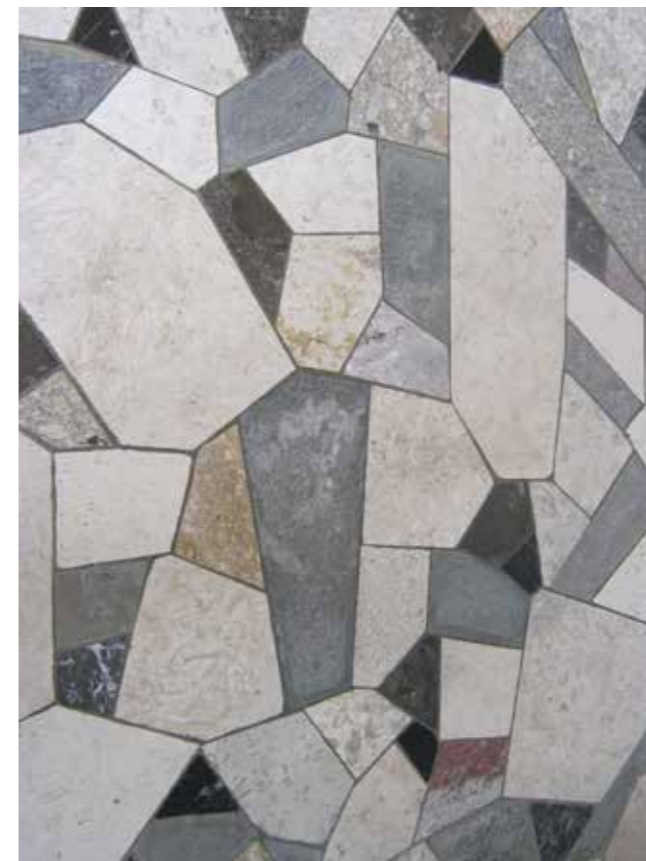
Slika 3: Kamniti tlak vhodne veže stavbe na Pristaniški 5 z raznobravno inkrustacijo. Foto: Neža Čebtron Lipovec, 2015
