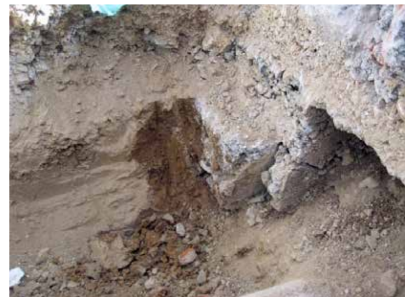
Slika 3: Temelj, izveden na kontaktu med glinenimi plastmi in kamnino. Figura 3: La fondazione effettuata al contatto tra gli strati di argilla e roccia.
