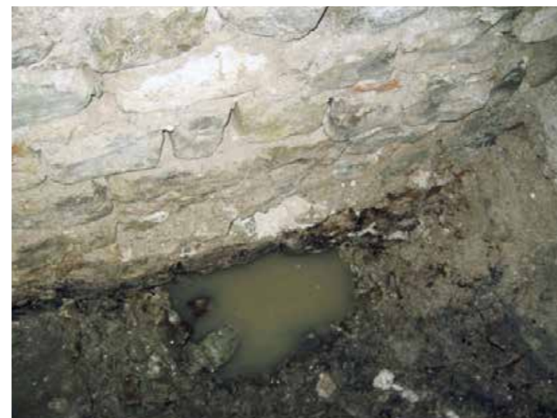
Slika 2: Sondažni jašek ob temelju cerkve. Figura 2: Valutazione della profondità della carbonatazione della malta cementizia con la fenolftaleina.
