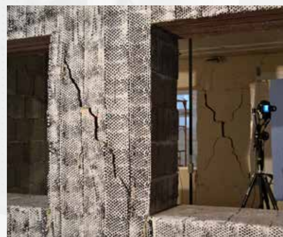
Potresna preiskava zidane stavbe v naravnem merilu (zgoraj) in diagonalne strižne razpoke v zidovih spodnje etaže (spodaj)
