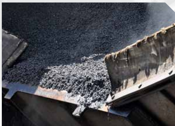
Vgradnja asfalta z umetnim agregatom iz jeklarske žlindre
