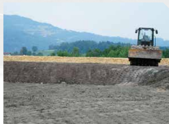
Vgradnja kompozita po plasteh pri revitalizaciji rudarskega prostora
