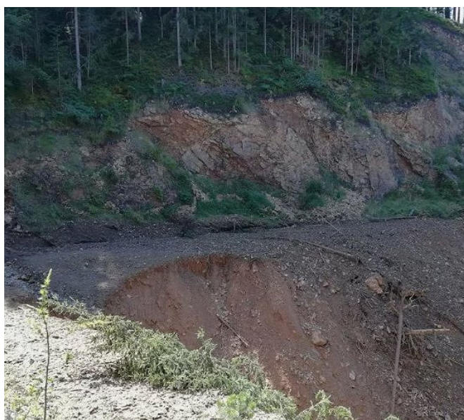
Slika 7: Drobirski tok je pri prečkanju gozdne ceste povzročil veliko erozijsko jedro
