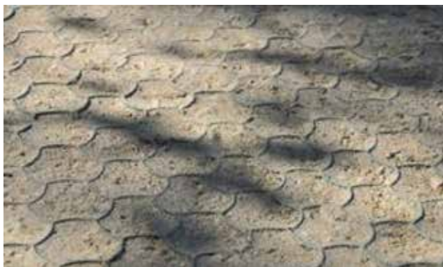
Slika 5. Geočelije u kolničkoj konstrukciji prije polaganja asfalta
